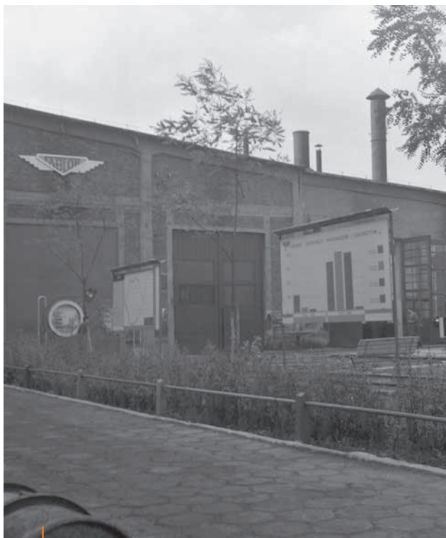
Budynek lakierni należącej do Wydziału Montażu Lokomotyw
