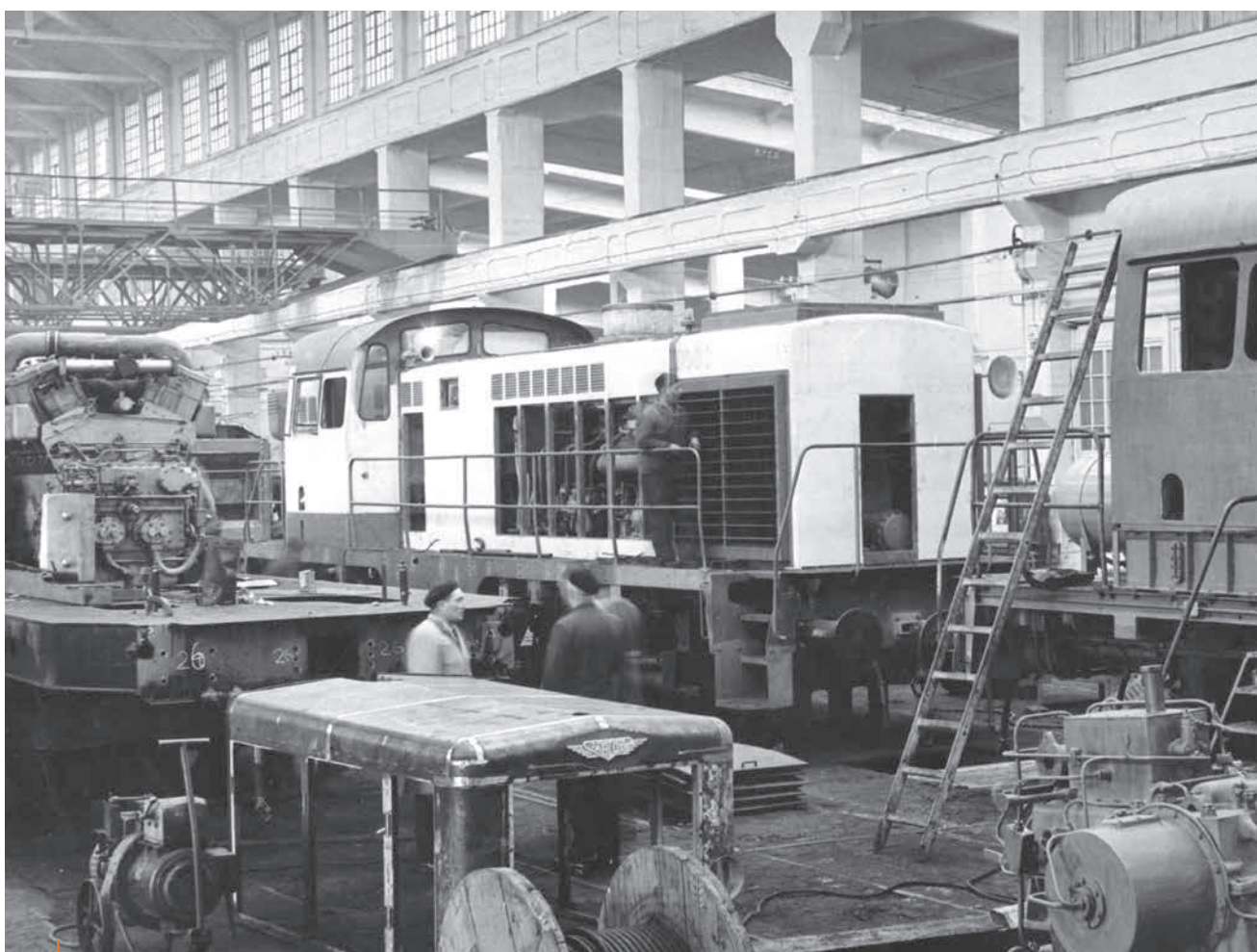
Prace przy montażu lokomotywy 6D (SM 800), lata 70. XX w.
