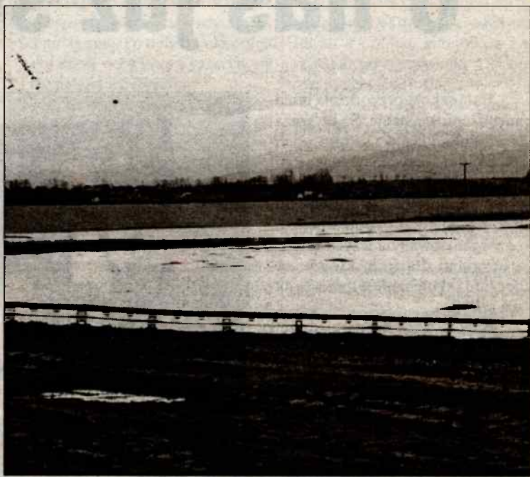
Niedokończona budowa zbiornika Kozielno
