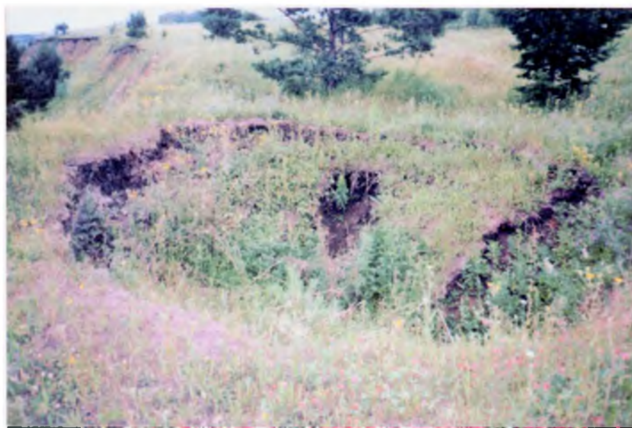
Фот. 3. Блоки отседания у верхней кромки отработанного карьера Черемховского угольного месторождения
