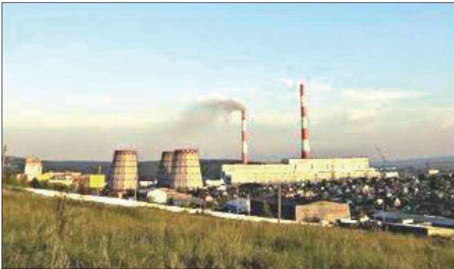
Фот. 5. Ново-Иркутская ТЭЦ (источник: интернет)
