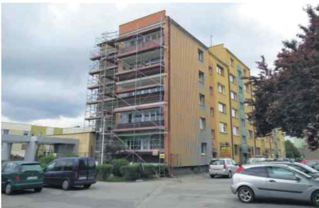
Wymiana blach na ocieplenie ze styropianu i czyszczenie elewacji przy ul. Tuwima 10-14.
