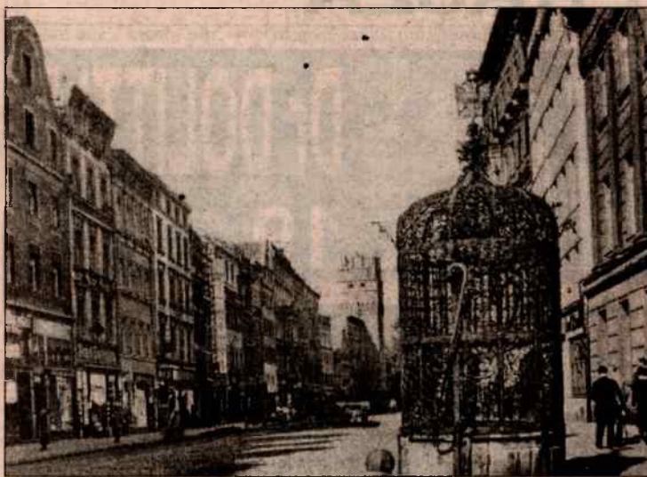
Widok studni sprzed 1939 r.
