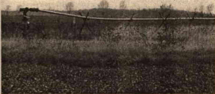
Zacopowane źródło wody mineralnej z prowizorycznym rurociągiem
