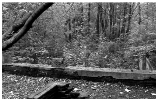
Zdegradowane i zarośnięte tereny dawnego kąpieliska (2017 rok)
