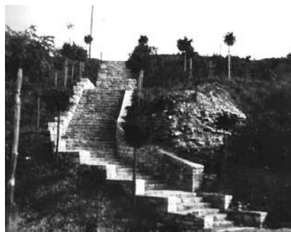
Schody prowadzące do Parku Ludowego (lata 40.)
