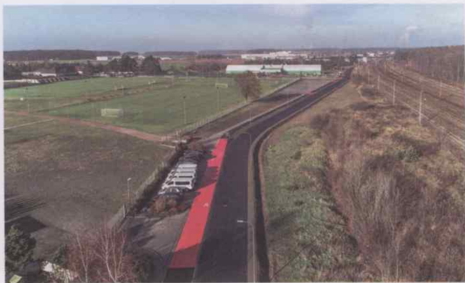
Przebudowana ul. Sportowa z lotu ptaka
