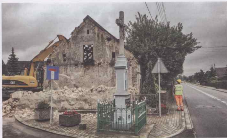
O zgodę na wyburzenie budynku walczyły władze samorządowe gminy Gogolin, jak również mieszkańcy
