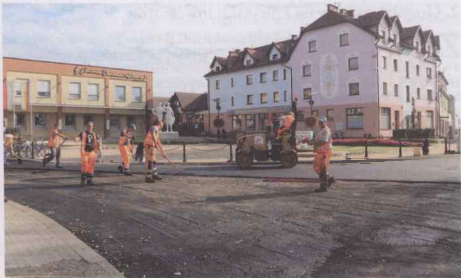
Plac Dworcowy w Gogolinie podczas modernizacji
