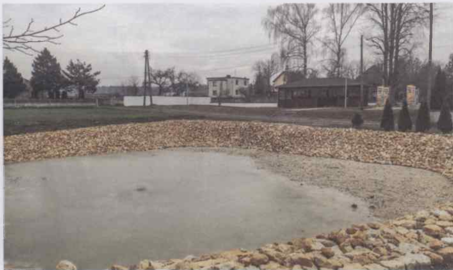
Dzięki kamieniowi wapiennemu, przekazanemu przez grupę Lhoist, staw w Kamionku pięknie wkomponował się w otoczenie
