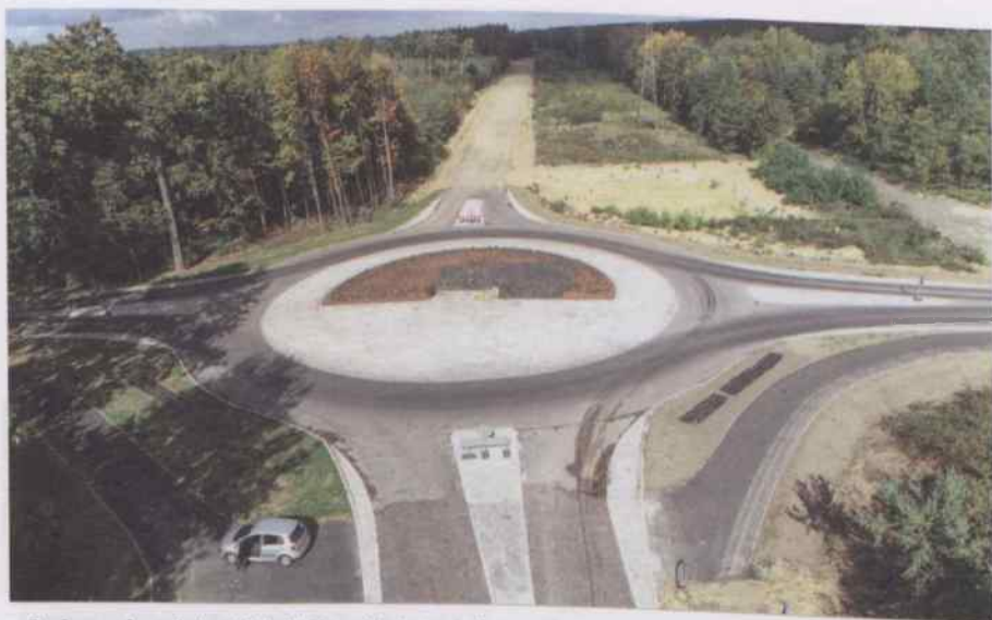
Budowa obwodnicy Malni i Choruli z lotu ptaka
