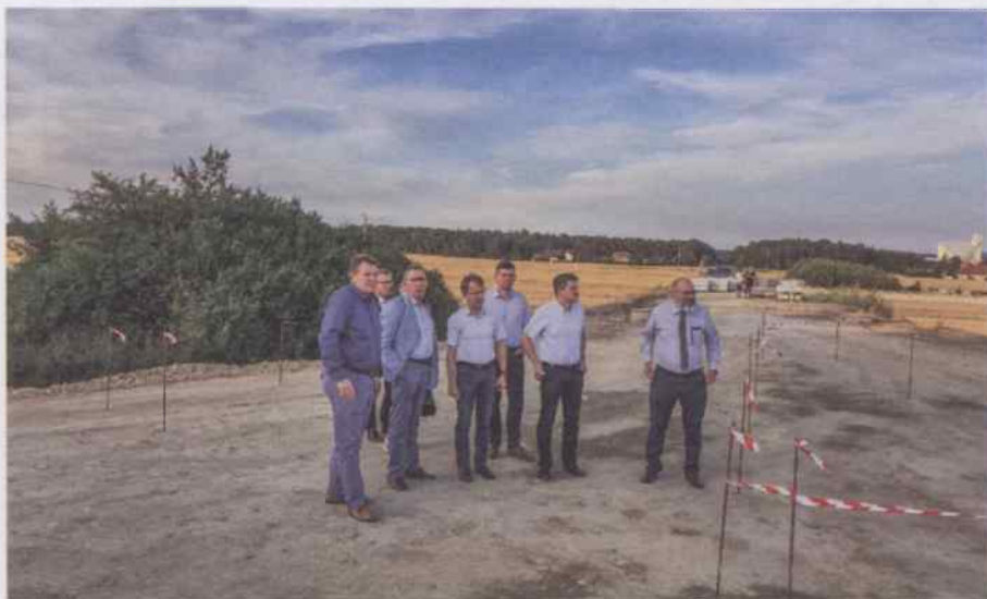
Członkowie Rady wizytowali m.in. plac budowy obwodnicy Malni i Choruli
