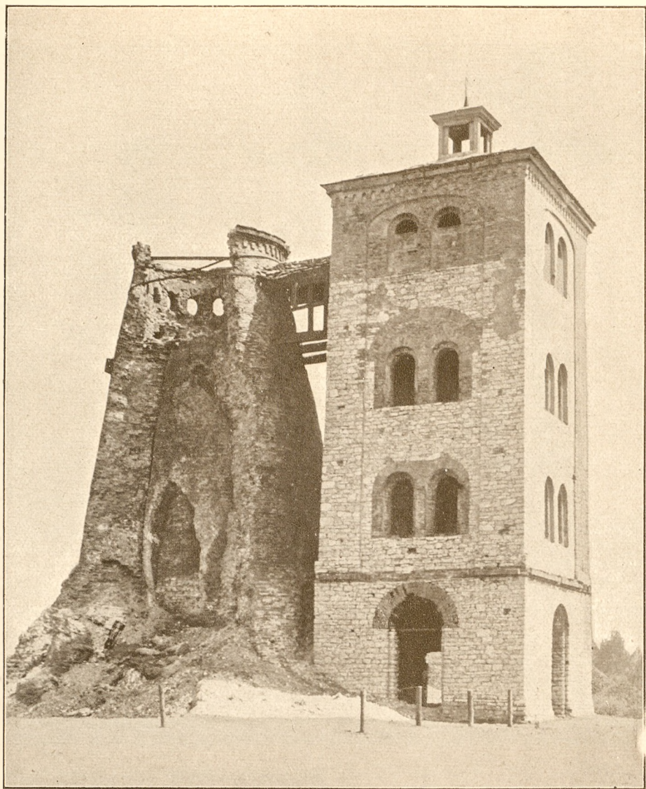
Aus den Anfängen der oberschlesischen Industrie. Verfallender alter Eisenschmelzofen an der Briniga.
