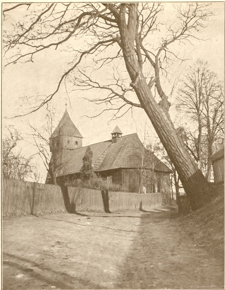
Die Holzkirche von Jedlowitz bei Loslau.
