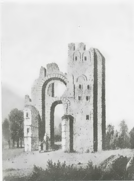
Rys. 58. Ruiny Złotej Bramy, czyli bramy złotników, [w Kijowie, p/g rysunku z 1651 r.
