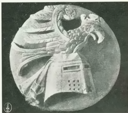
Rys. 131. Zwornik na sklepieniu z XIV w. w Rynku krakowskim Nr. 17 (Bakowski, Dzieje Krakowa).
