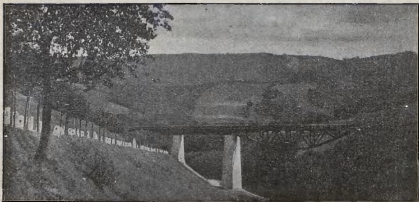
Schleifertal, Eisenbahnbrücke am Hemmstein.
