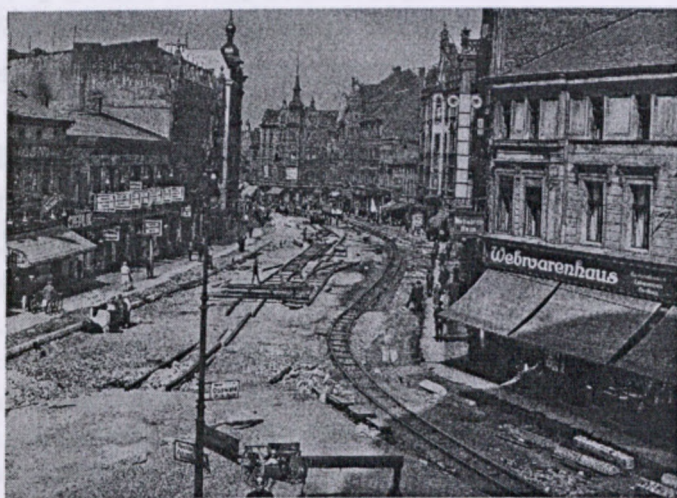
Zabrze ul. Wolności. Przekuwanie torów linii Gliwice – Chebzie. (1929)
