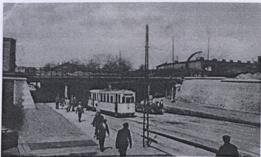
Sosnowiec - przejazd pod „Mostem Katowickim” w kierunku ulicy Sobieskiego
