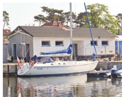
Nowe sanitariaty obok betonowego slipu.
