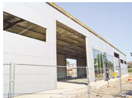
Budynek ma duże bramy wjazdowe.
