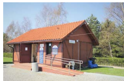
Budynek portowy przystani w Rybinie.
