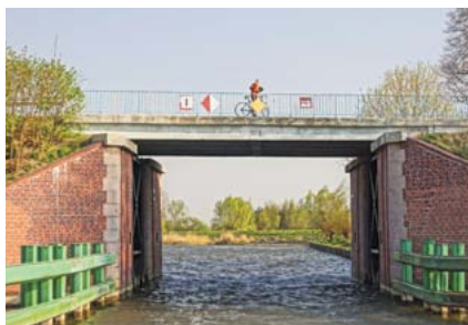
Wrota przeciwpowodziowe i Kanał Jagielloński.
