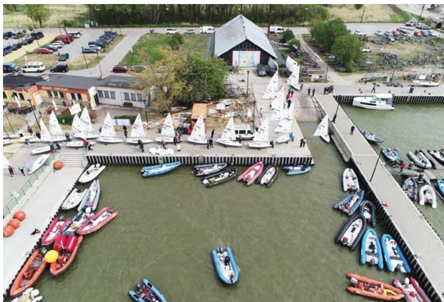
Basen wewnętrzny z dużym betonowym slipem.
