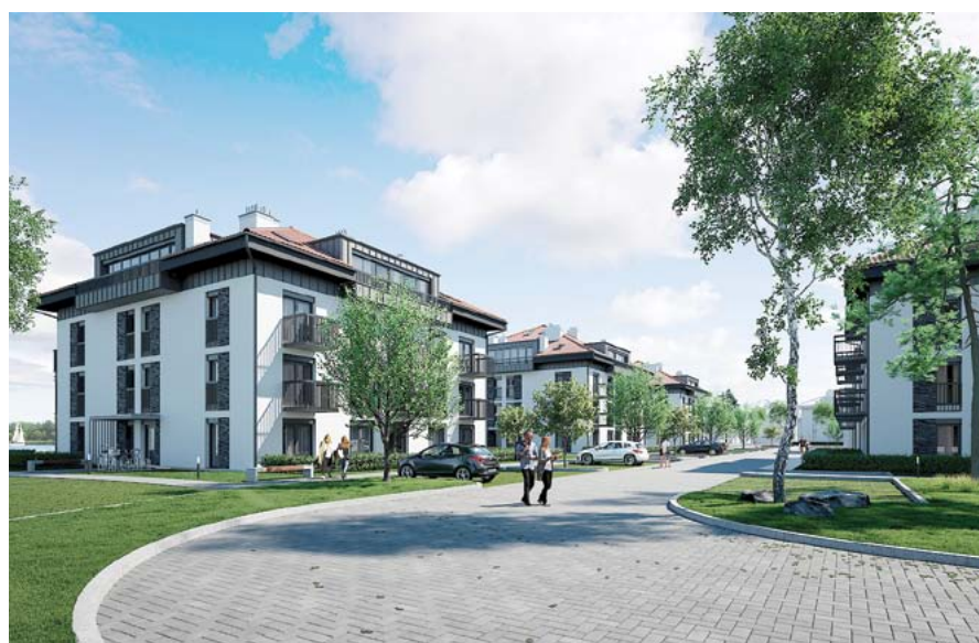
W pierwszym etapie powstanie pięć budynków.
