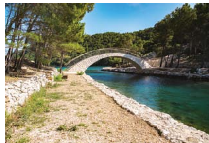
Most przy osadzie Soline.
