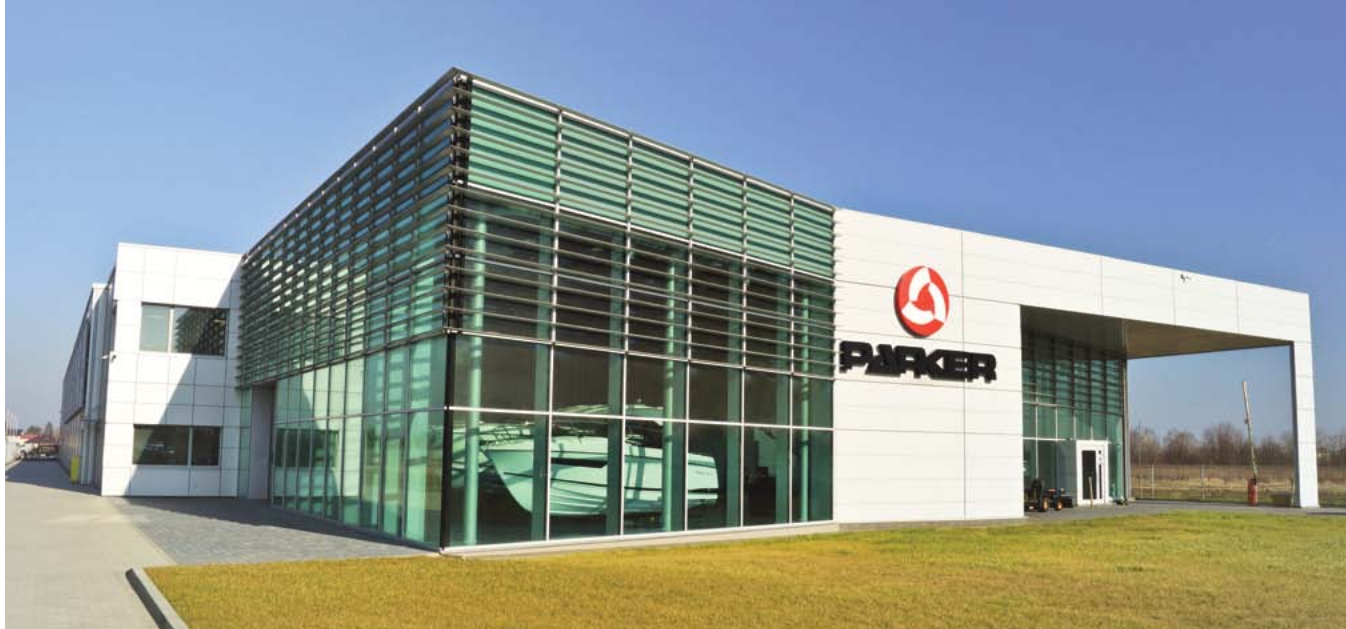
Rozbudowana i zmodernizowana siedziba firmy Parker Poland (Cząstków Polski, 12 km od północnej granicy Warszawy).
