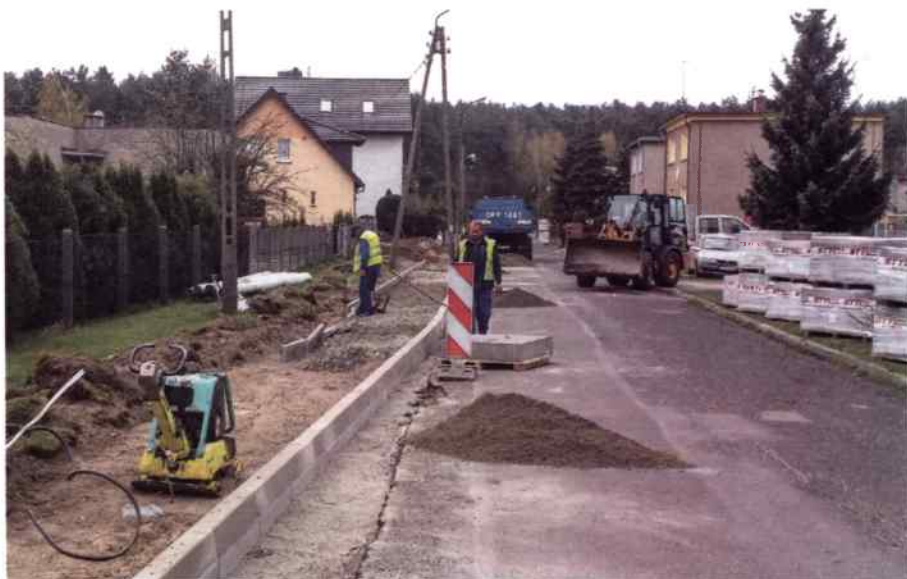
Remont ul. Leśnej
