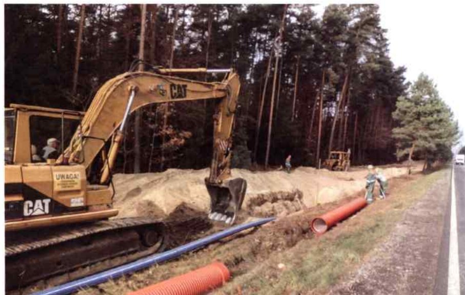
Realizacja inwestycji między Gogolinem a Górażdżami
