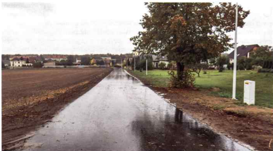
Przy ulicy ustawiono nowoczesne lampy
