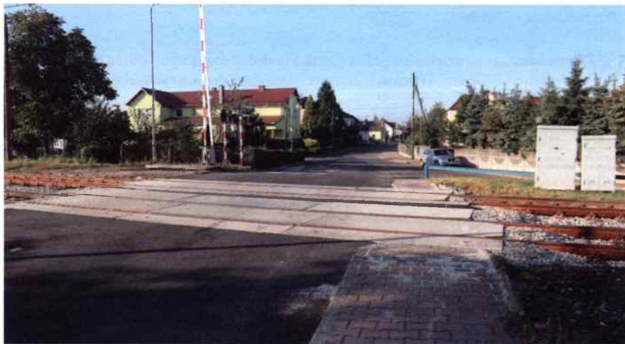
Przejazd przez tory stał się bezpieczniejszy
