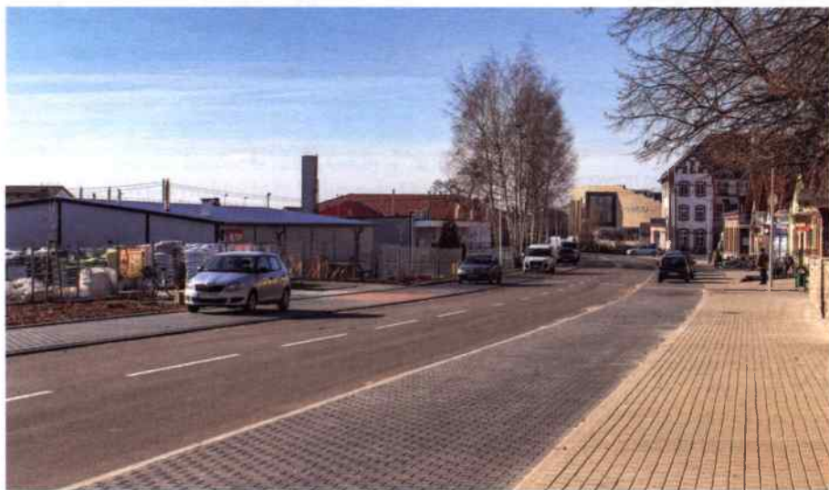
Przebudowana ul. Pawła
