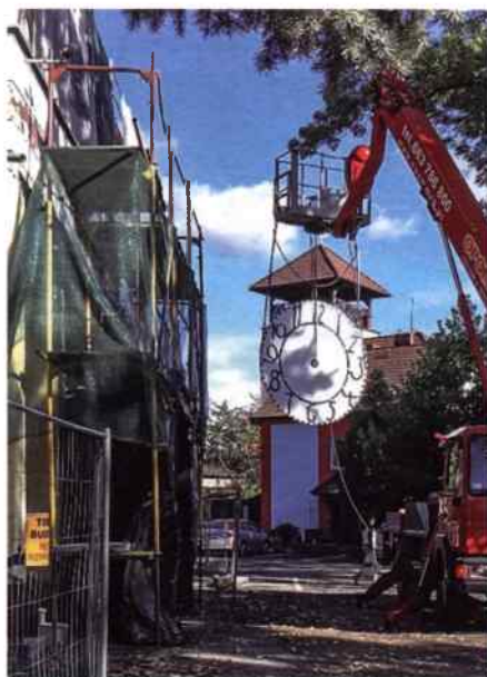
Montaż tarczy zegara na budynku Urzędu Miejskiego
