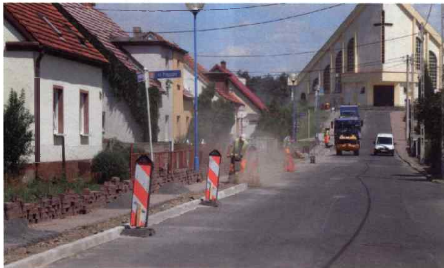
Ulica Przyjaciół Schongau uzyskała nową nawierzchnię, wymieniono również krawężniki
