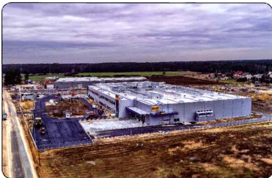
Budowa fabryki Hengst
