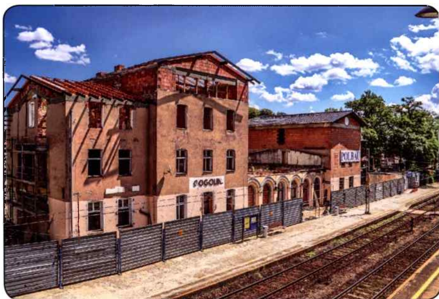
Budowa Centrum Przesiadkowego
