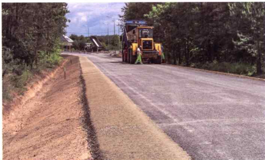
Wykonawcą inwestycji była firma OLS z Lublińca.
