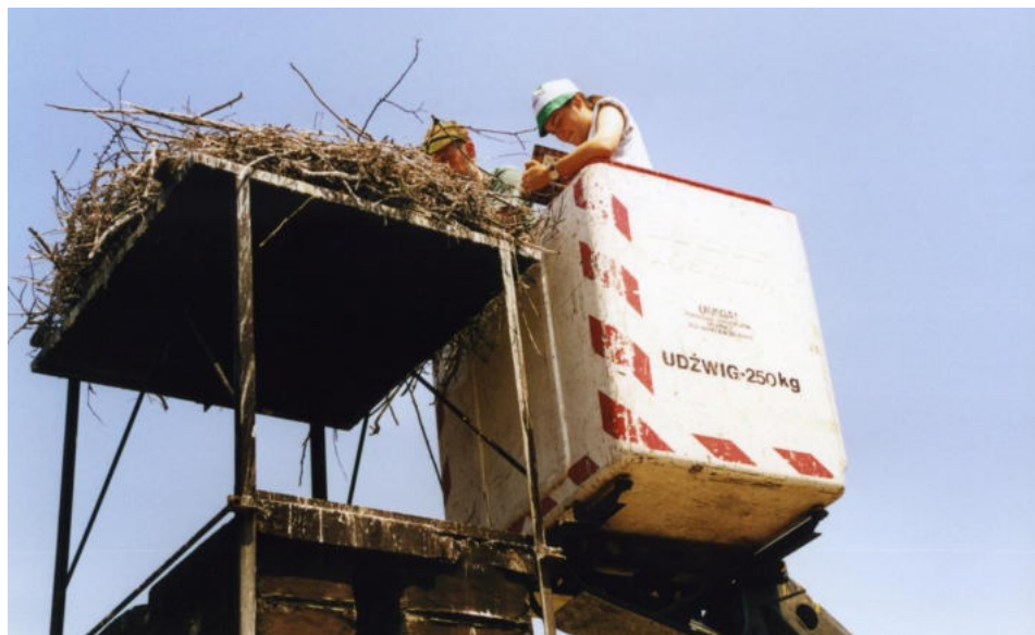
Ryc. 4.5. Platforma gniazdowa na kominie w Halembie. Fot. K. Henel (2000) Fig. 4.5. Nesting platform on the chimney in Halemba. Photo by K. Henel (2000)
