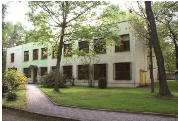
Ryc. 13.3. Budynek Zakładu Gospodarki Leśnej Rejonów Przemysłowych Instytutu Badawczego Leśnictwa przy ul. św. Huberta 35 w Katowicach-Brynowie. Fot. J. B. Parusel (11.05. 2016 r.).
