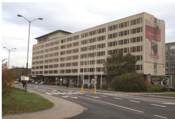
Ryc. 13.4. Obecnie biuro Centrum Dziedzictwa Przyrody Górnego Śląska mieści się w budynku firmy Bipromet S.A. w Katowicach przy ul. Granicznej 29. Fot. J. B. Parusel.
