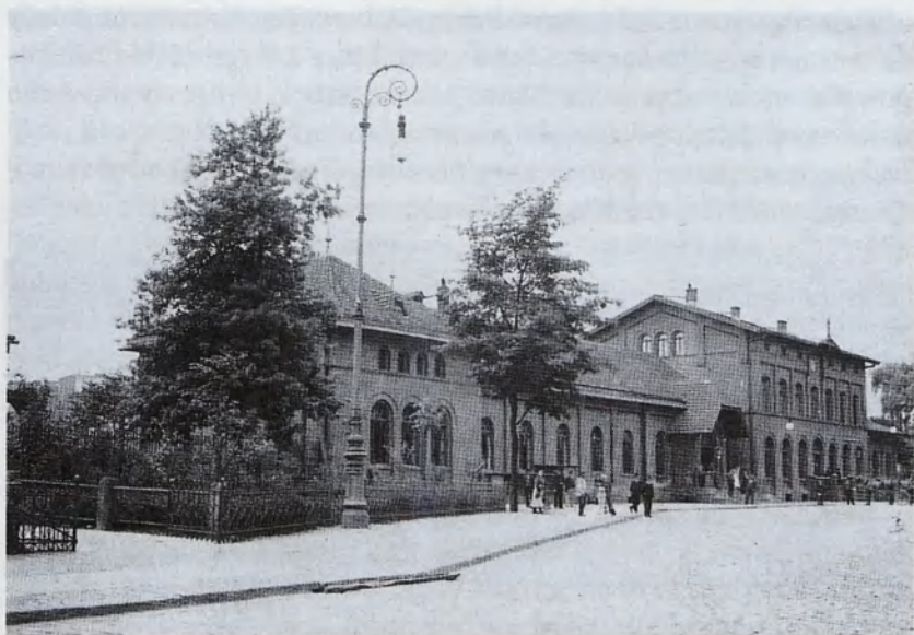
Plac Dworcowy w Zabrzu. Nieistniejące zabudowania dworca kolejowego
