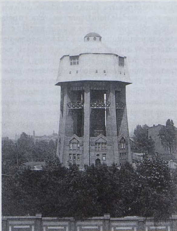
Wieża ciśnień, 1914 r.
