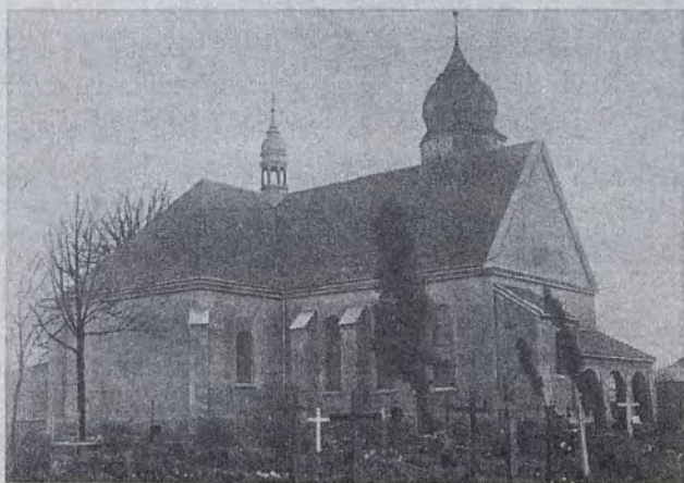
Włdok rozbudowy kościoła parafjalnego w Lubszy (ze strony północnej).
