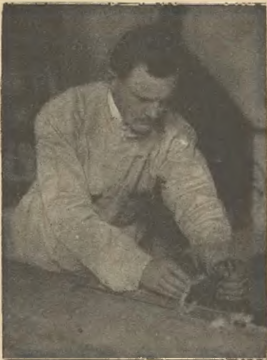
Rys. 41. a. Sposób trzymania struga przy robocie.
