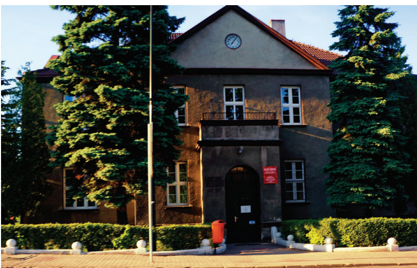
Budynek z czasów współczesnych – dzisiejsza siedziba Miejskiego Ośrodka Pomocy Rodzinie.
