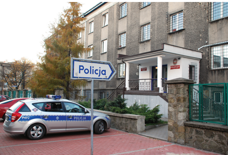
Budynek Komendy Miejskiej Policji w Piekarach Śląskich przed termomodernizacją.
