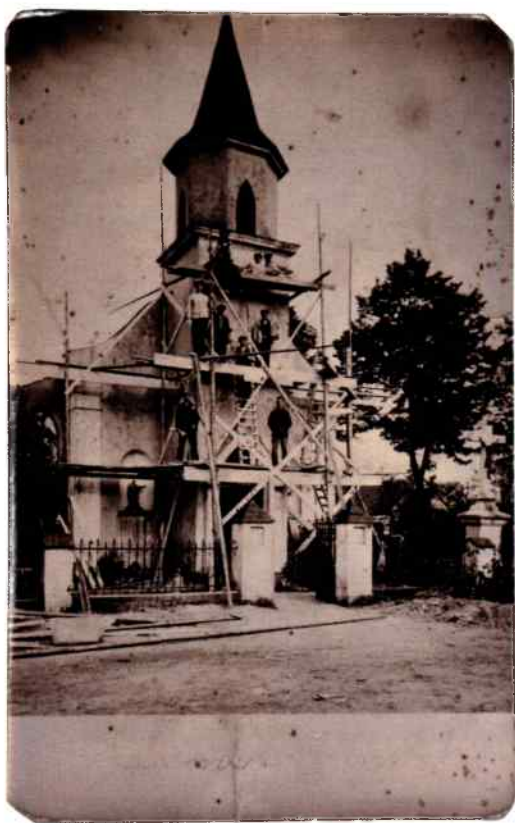
Remont dachu i elewacji kościoła, 1930 r./ Renovierung des Daches und der Fassade der Kirche im Jahre 1930
