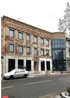
60. Budynek przy ulicy Bytomskiej 166. Fot. Jakub Müller, 2019 r.
