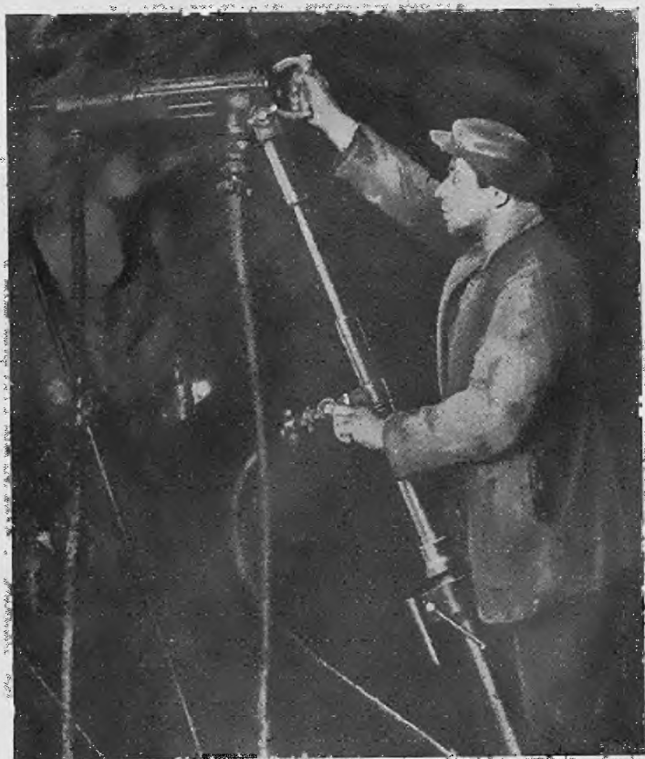
Abb. 101. Flottmann-Druckluft-Bohrknecht Das Bohren mit Flottmann-Spülkopf im Querschlagvortrieb.
