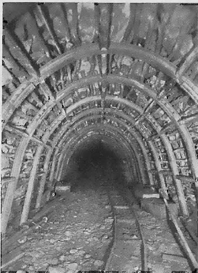
Abb. 5. Starrer Stahlstredenausbau aus Potaleisen als dreiteiliger Gestellbogenausbau in einem Ortsquerschlag
