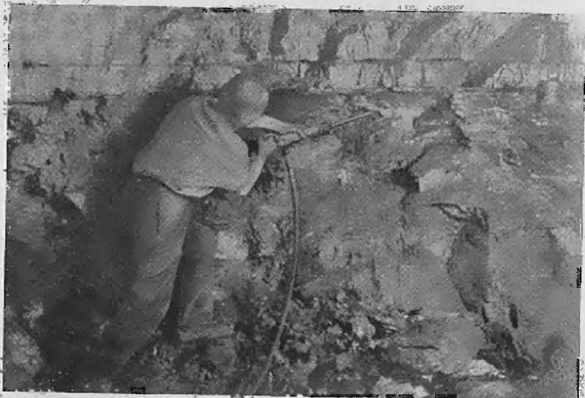
Abb. 5. Arbeitsweise mit dem Abbaupanimer, rechtwinklig zu den Schichten (Werkphoto Flottmann A. G.)
