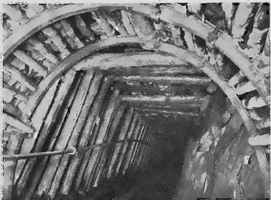
Abb. 37. Dreiteiliger, nachgiebiger Toussaint-Heinemann-Gestellbogenausbau in einer Flözstrecke
