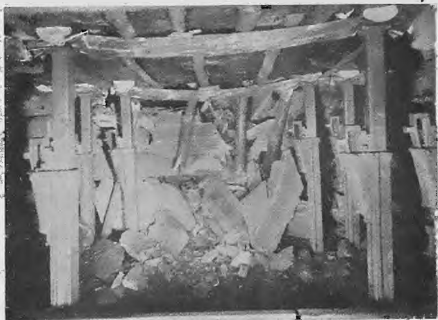
Abb. 35. Bruch des Sandstieferhängenden nach dem Ausrauben der Stahlstempel in einem planmäßig geführten Bruchbau.
