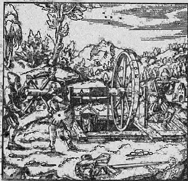
Abb. 5. Windenantrieb von Hand
