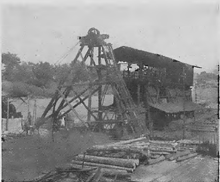
Abb. 7. Förderung über Seilscheiben in einem tonnlägigen Schacht
