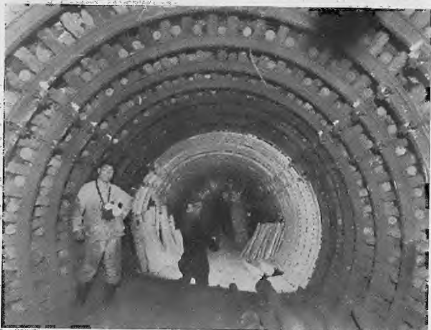
Abb. 40. Dreiteiliger Toussaint-Heinemann-Ringausbau beim Umbau einer Hauptförderstrecke
