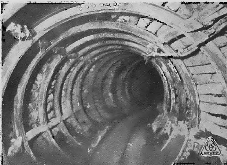
Abb. 22. Dreiteiliger Ringausbau aus Breitflanschträgern auf Mine Tscherno bei Burgas, Bulgarien
