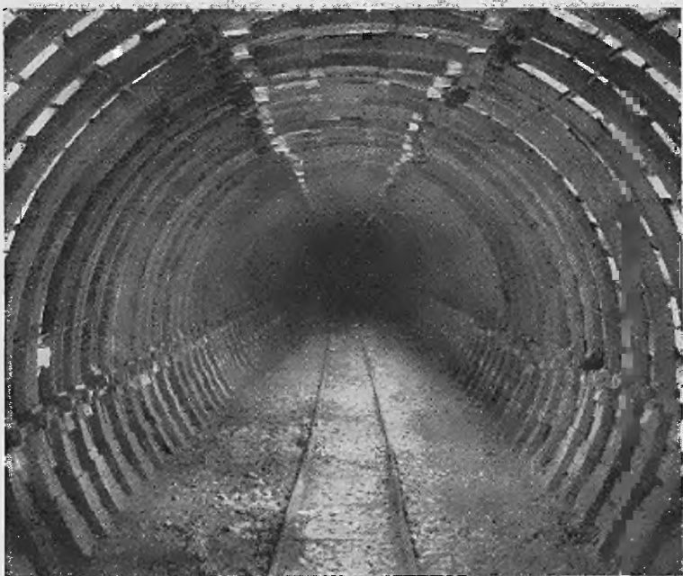
Abb. 30. Nachgiebiger Ringausbau aus U-Eisenprofilen.
