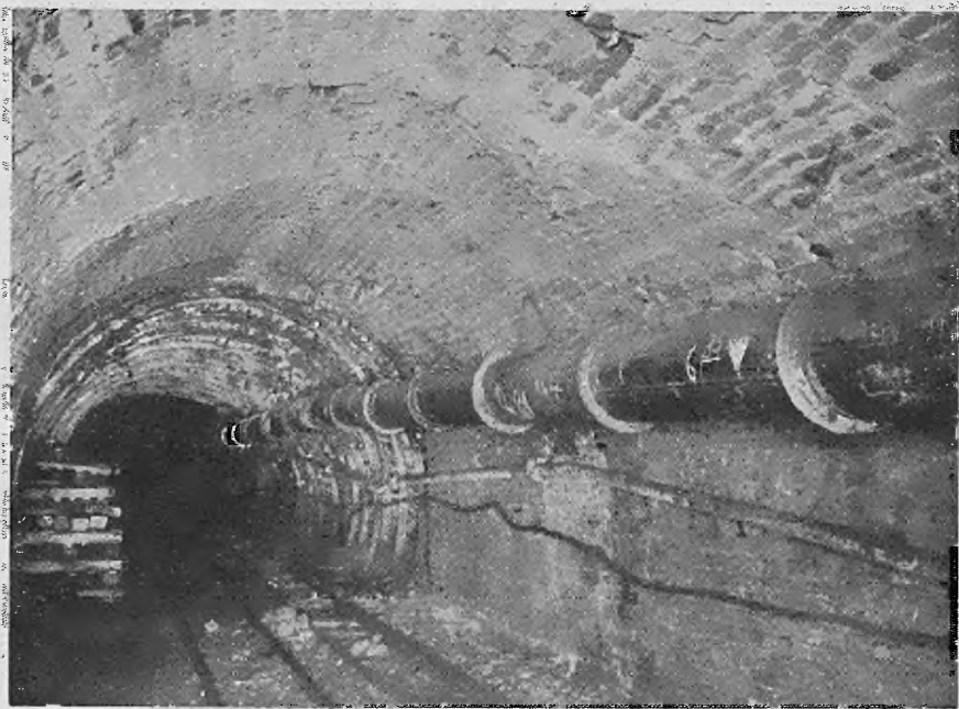
Abb. 38. Der Toussaint-Heinmann-Gestellbogenausbau ersetzt die Siegelsteinmauerung in einer starr unter Druck stehenden Förderstrecke.
