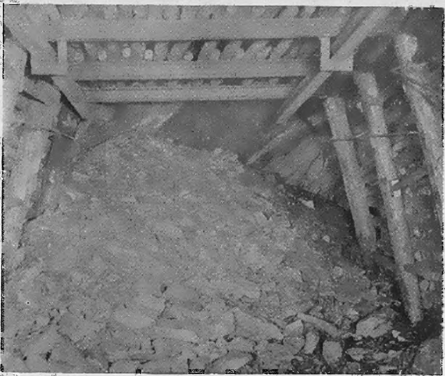
Abb. 45. Der abgeschossene Ab Schlag im Ortsvertrieb (Wertphoto Heint. Koefmann jr.).
