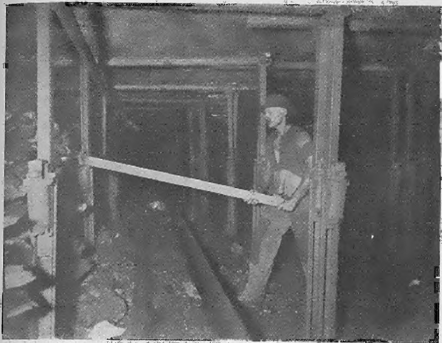
Abb. 41. Räuben des Toussaint-Heinmann-Stahlstempels
