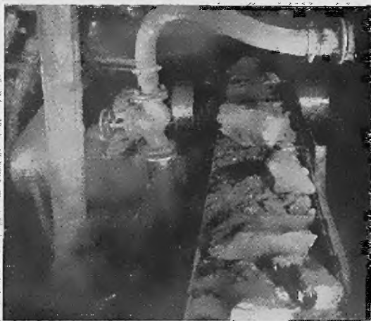
Abb. 74. Antriebsstation beim Stahlgliedertransportband (Werfphoto: Smihince).
