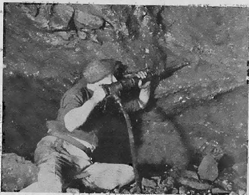
Abb. 6. Arbeitsweise mit dem Abbaupanimer, parallel zu den Schichten (Werkphoto Flottmann A. G.)
