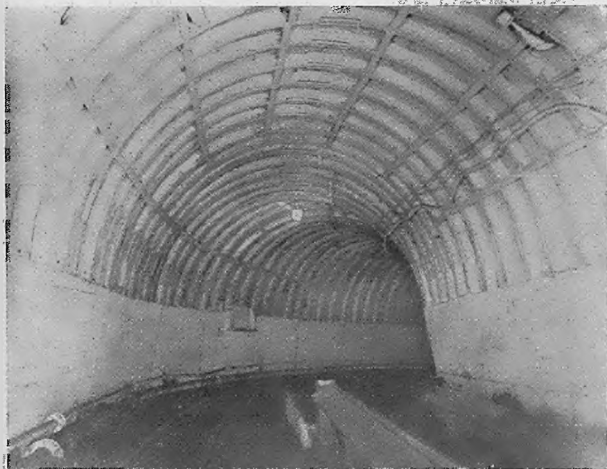
Abb. 10. Dreiteiliger Potaleisenausbau in starrer Ausführung auf einem Füllort
