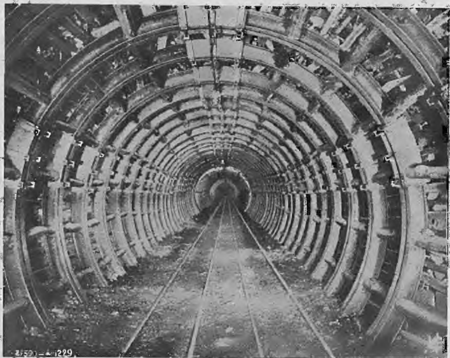
Abb. 29. Vierteiliger nachgiebiger Ringausbau, wobei die Rahmenprofile in doppelter Anordnung eingebaut sind (schwerer Ausbau)
