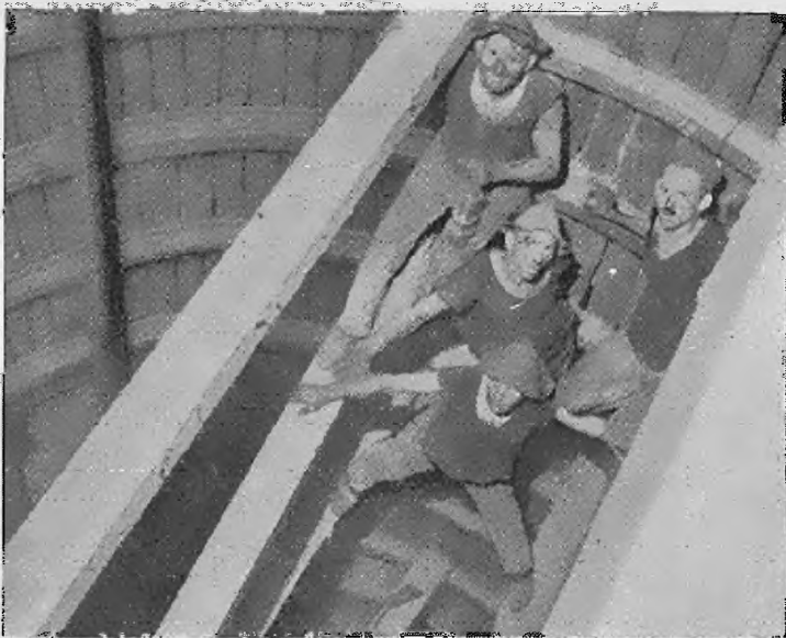
Abb. 83. Eisenrundausbau im Stapel mit Toussaint-Heinemann-Profil
