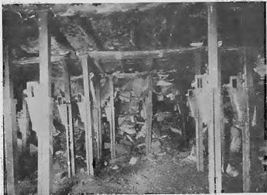
Abb. 34. Bruch des Schieferhängenden nach dem Ausrauben der Stahlstempel in einem planmäßig geführten Bruchbau.
