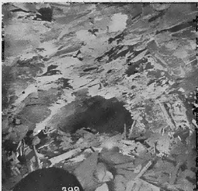
Abb. 51. Ausgeraubte Strecke, in der Moll-Eisenpolygonausbau eingebracht war
