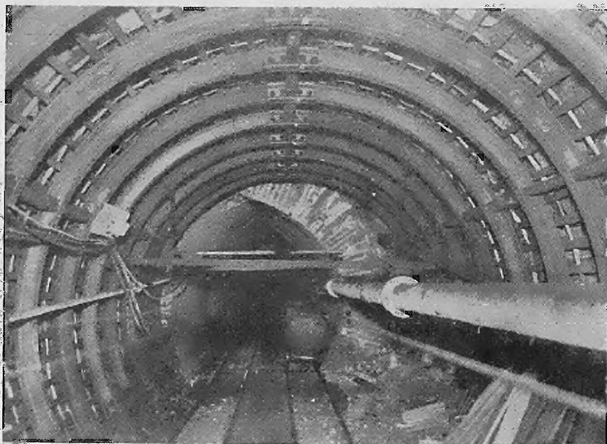
Abb. 9. Dreiteiliger Ringausbau aus Pofaleisen in starrer Ausführung zum Nachbauen einer in Siegelsteinmauerung ausgebauten verdrückten Hauptförderstrecke
