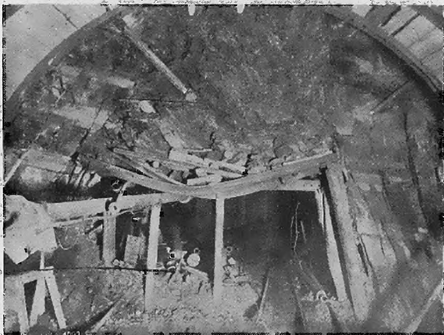
Abb. 45. Türstockausbau, zerstört durch die innerhalb der entspannten Zone liegenden Last
