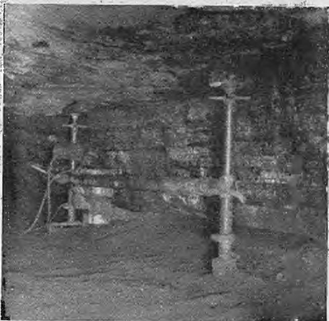
Abb. 36. Beendigung des Schrämens mit der Säulenschräummaschine, Type S/S (Wertphoto Heint. Kortmann jr.).
