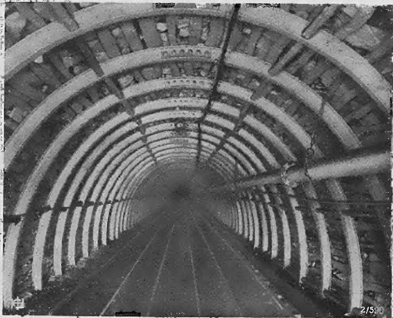
Abb. 26. Zweiteiliger Gestellbogenbau aus symmetrischen Profilen in offener Ausführung.
