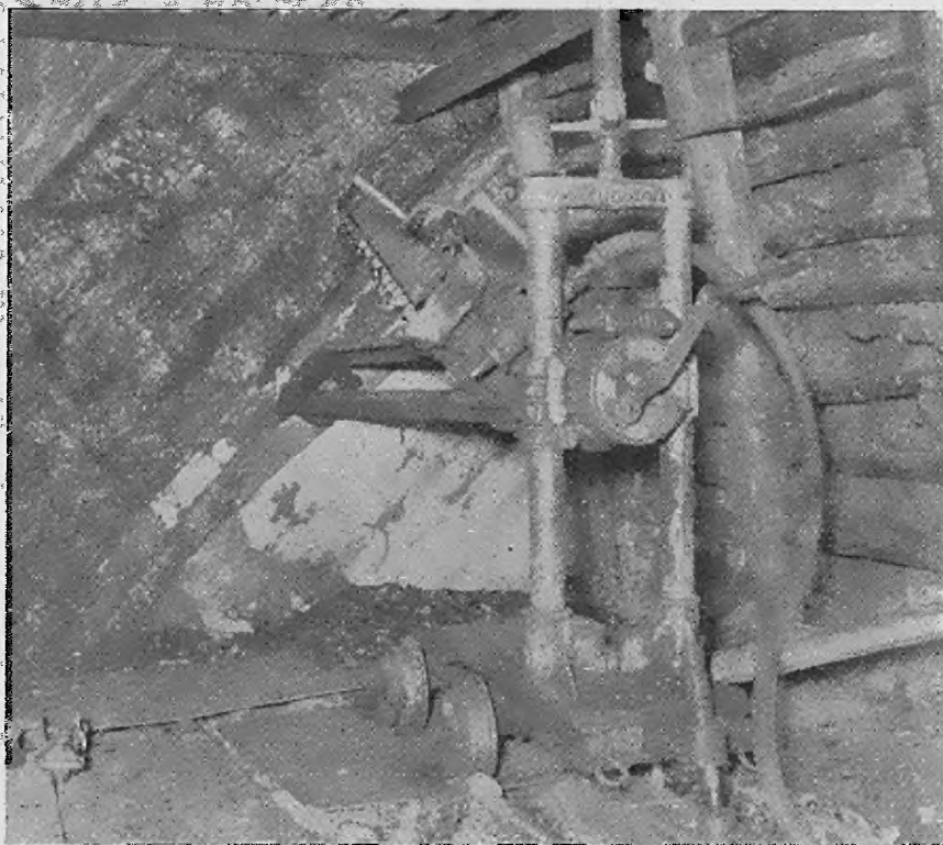
Abb. 42 Aufgebaute Säulenschräg- und Schligmaschine S/S/K vor Ort; fertig zum Schrägen (Wertphoto: Heinr. Korfmann Jr.).
