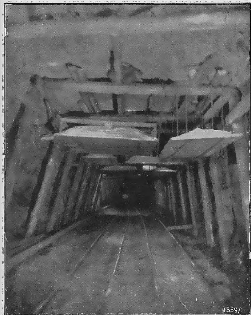
Abb. 90. Hauptsperre in einem aufsteigenden Querschlag
