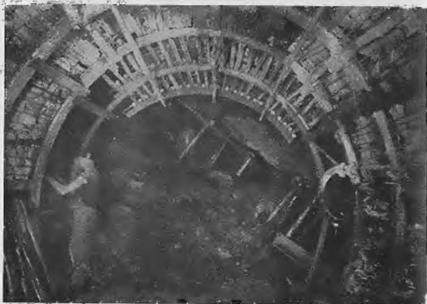
Abb. 41. Dreiteiliger Gestellbogenausbau aus Toussaint-Heinemann-Profil im Ortsvertrieb in halbfester Lagerung. Die Vorpfindung der Füsse erfolgt durch Halteeisen
