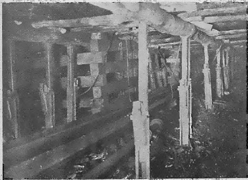
Abb. 33. Holzpfiler aus scharfkantig geschnittenen Hartbölzern für den starren Ausbau im Streb
