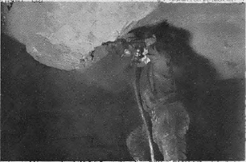
Abb. 20. Der Abbauhammer beim Nachholen der Furte im Querschlagvortrieb (Wertphoto Flottmann A. G.).
