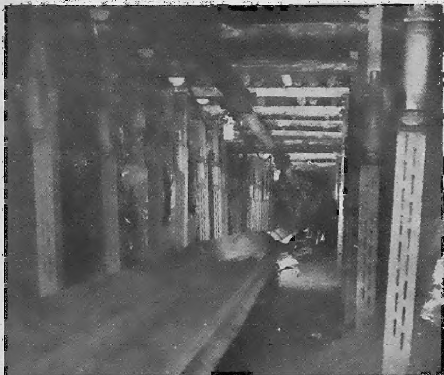
Abb. 50. Strebausbau mit starren Stempeln der Gutehoffnungshütte
