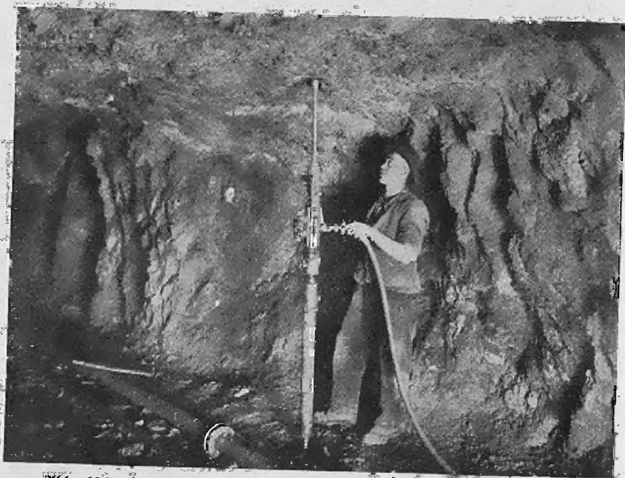
Abb. 104. Haltevorrichtung für Bohrhammer mit pneumatischem Vorschub
