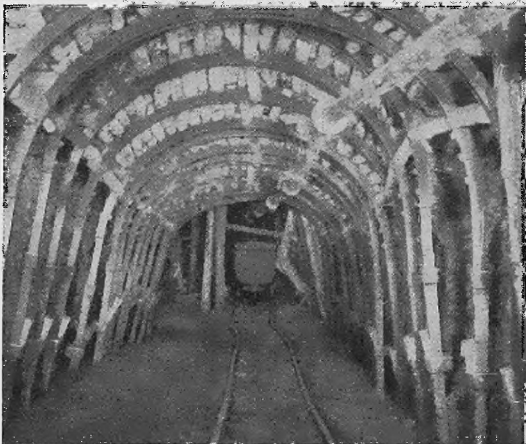
Abb. 31. Nachgiebiger Gestellbogensausbau aus U-Eisenprofilen
