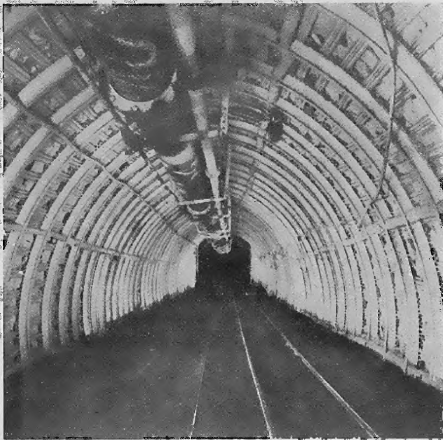
Abb. 27. Zweiteiliger Gestellbogenausbau aus symmetrischen Profilen und Stahlspeichenverzug in starrer Ausführung
