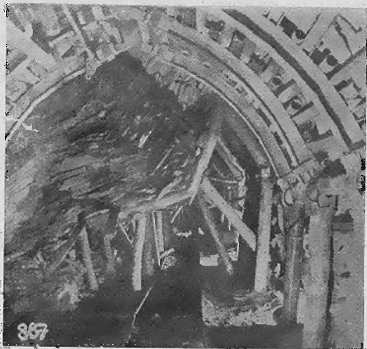
Abb. 59. Moll-Eisenpolygonausbau beim Nachbauen einer in Holz ausgebauten Abbaustrecke
