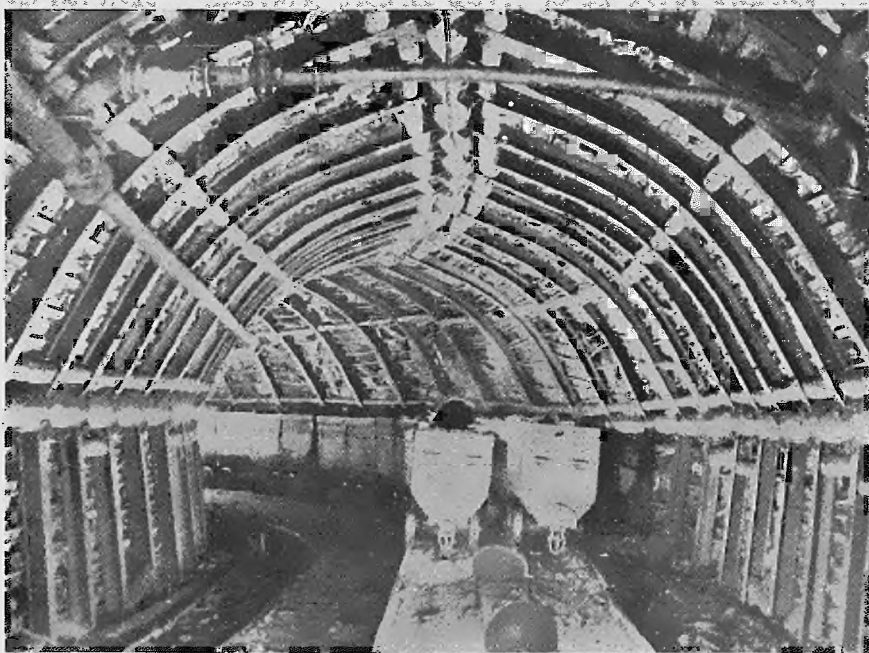
Abb. 56. Moll-Eisenpolygonausbau am Eingang einer Nichtstrecke
