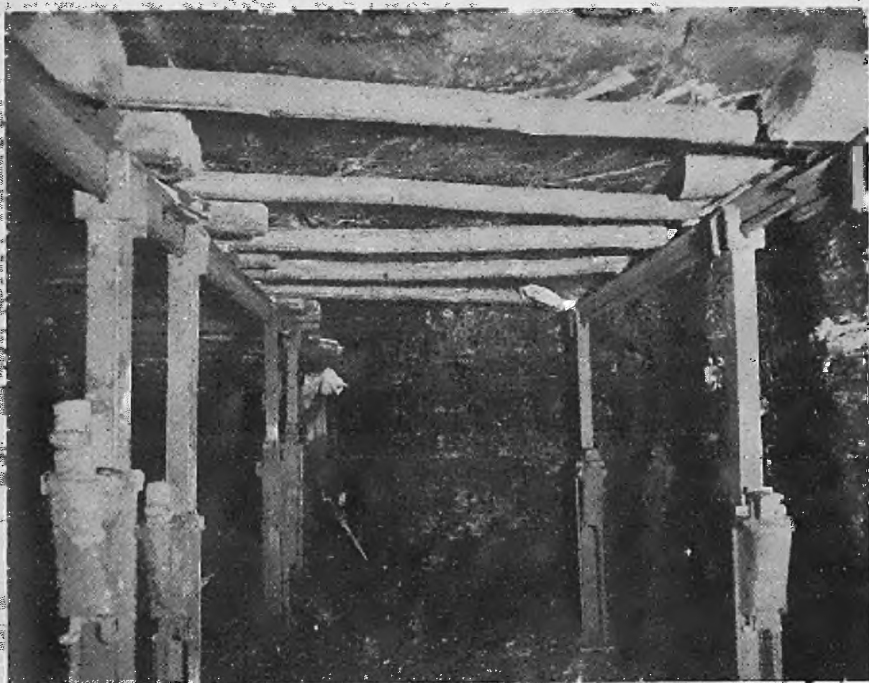
Abb. 39. Strebaustrau mit Toussaint-Heinmann-Stahlstempel unter Verwendung von Doppel-T-Trägern am Hängenden
