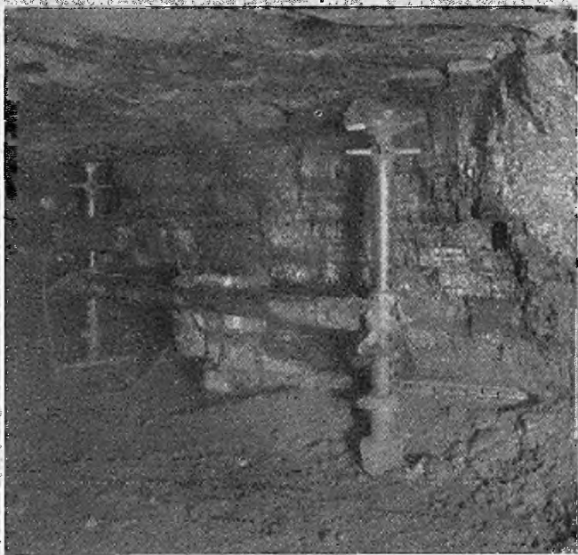
Abb. 35. Beginn des Schrämens mit der Säulenschräummaschine, Type S/S (Wertphoto Heint. Kortmann jr.).
