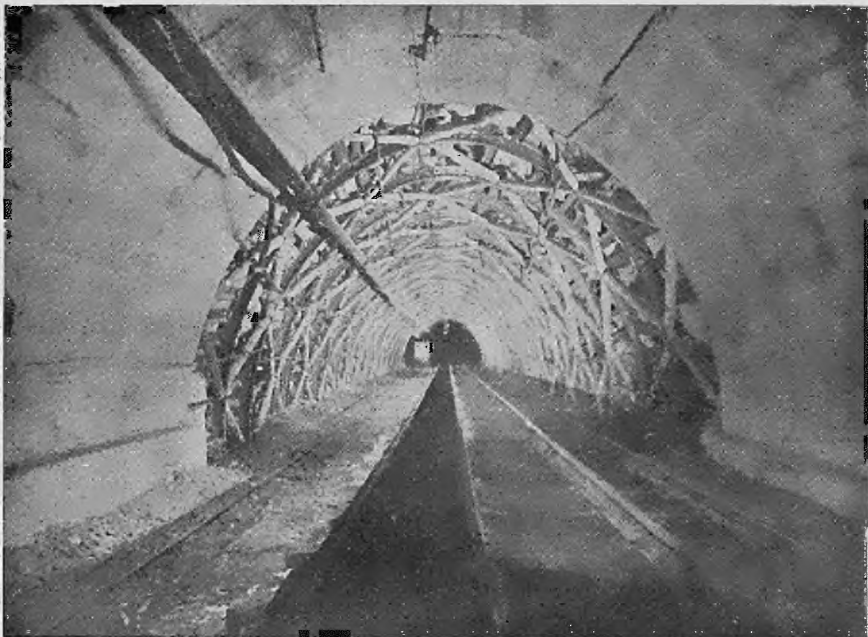
Abb. 11. Starrer Gestellbogenausbau aus Potaleisen mit eisernen Verstrebungen
