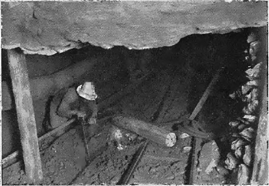
Abb. 19. Der Abbauhammer beim Spiken von Bühnlöchern (Wertphoto Flottmann A. G.).
