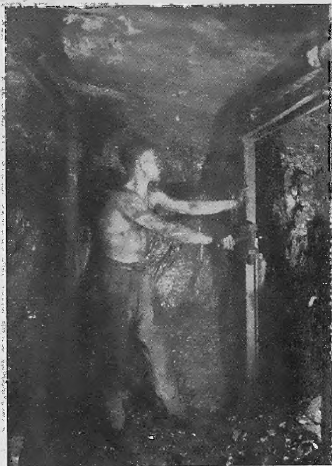
Abb. 40. Setzen des Foussaint-Heinckmann-Stahlstempels
