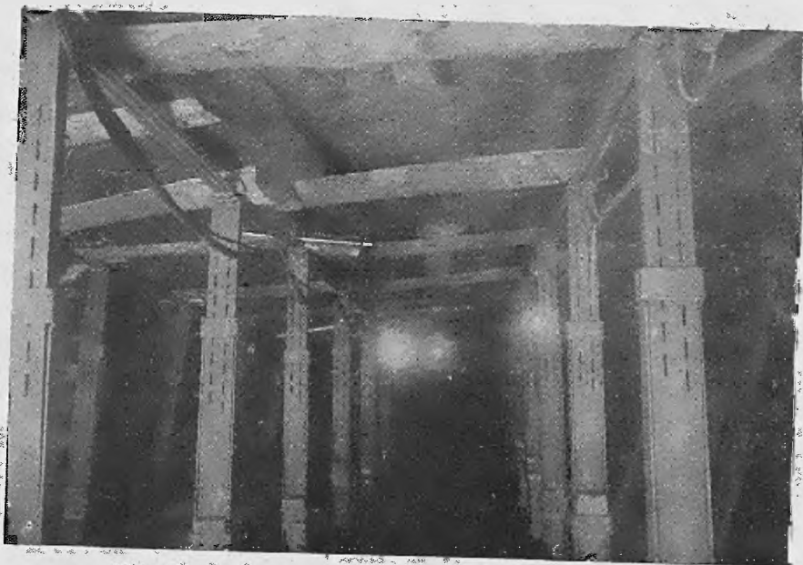
Abb. 53. Strebaubau mit nachgiebigen Schwarz-Stahlstempeln.
