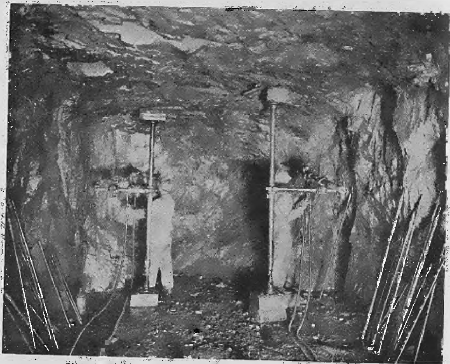
Abb. 102. Haltevorrichtung für Bohrhämmer mit Spannsäule
