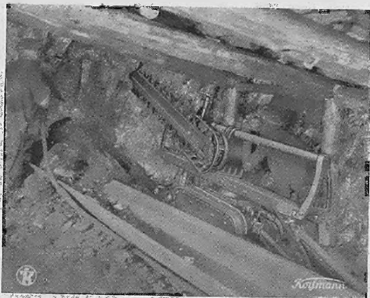
Abb. 49a. Einbruchferbmäschine beim Kerben in einem Aufhauen (Wertphoto Heint. Korfmann jr.).
