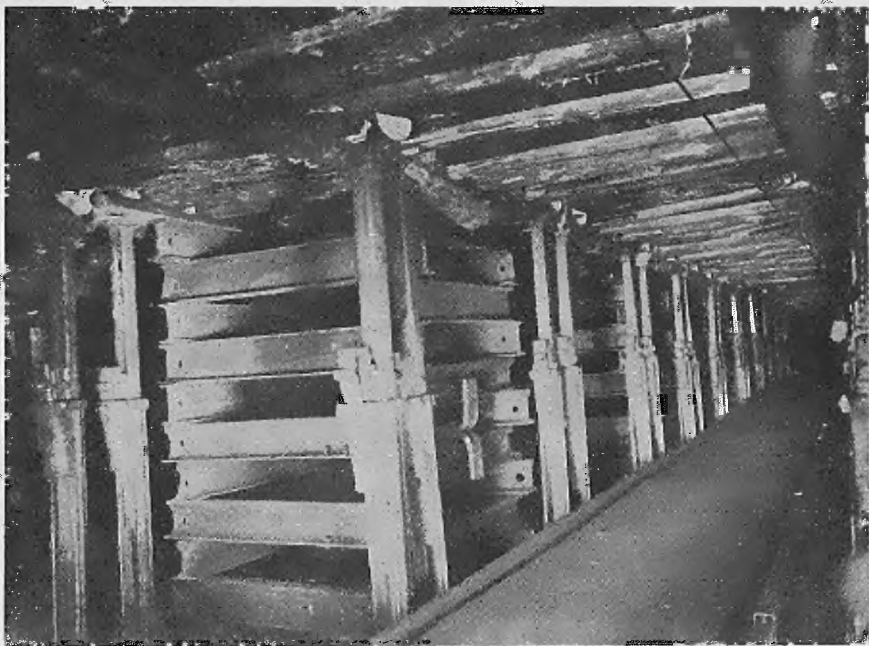
Abb. 32. Eisenpfeller für den starken Ausbau im Stieb
