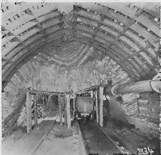
Abb. 57. Moll-Eisenpolygonausbau beim Nachbauen einer Hauptförderstrecke. Die Siegfelstunmauerung hat den auftretenden Druck nicht standhalten können
