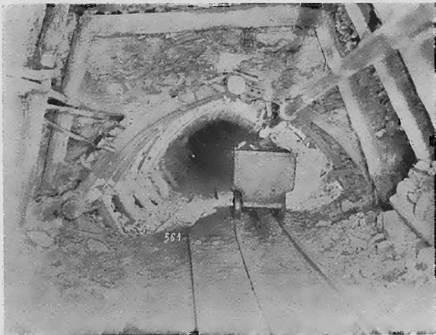
Abb. 47. Stark unter Druck stehender Moll-Eisenpolygonausbau
