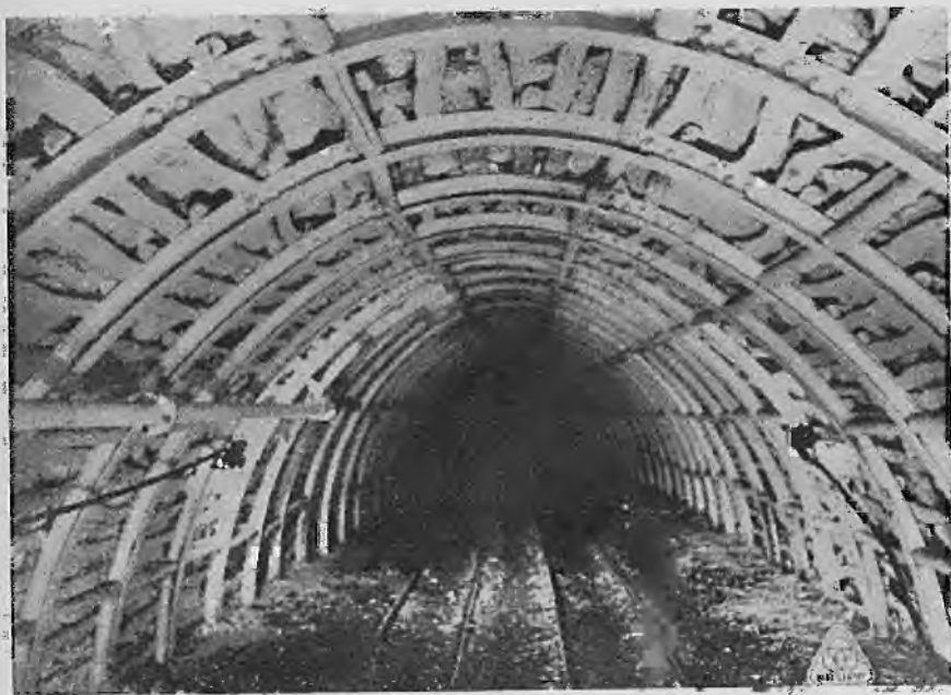
Abb. 19. Dreiteiliger Gestellbogenanubau aus Breitflanschträgern
