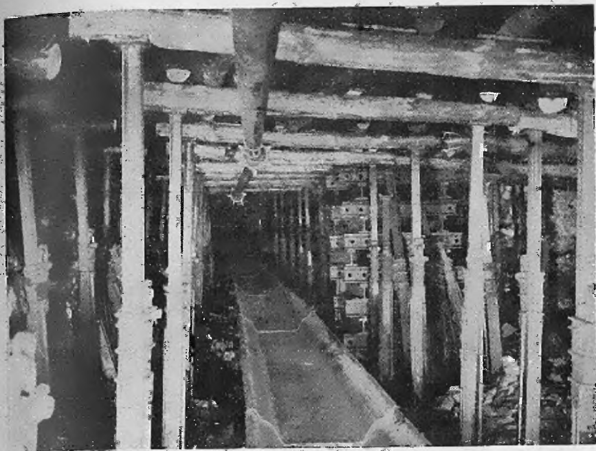
Abb. 43. Strebäusbau mit Toussaint-Heinemann-Stahlstempel mit Stahlgußkeiltasche
