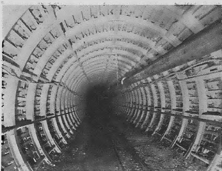
Abb. 6. Dreiteiliger Ring für Grubenausbau aus Kotalleisen in stativer Ausführung im Hauptquerschlag
