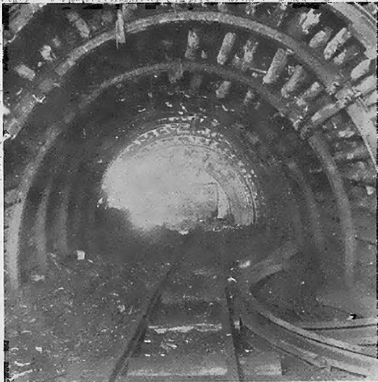
Abb. 42. Dreiteiliger Gestellbogenausbau aus Toussaint-Heinemann-Profil nach einem Gebirgschlag
