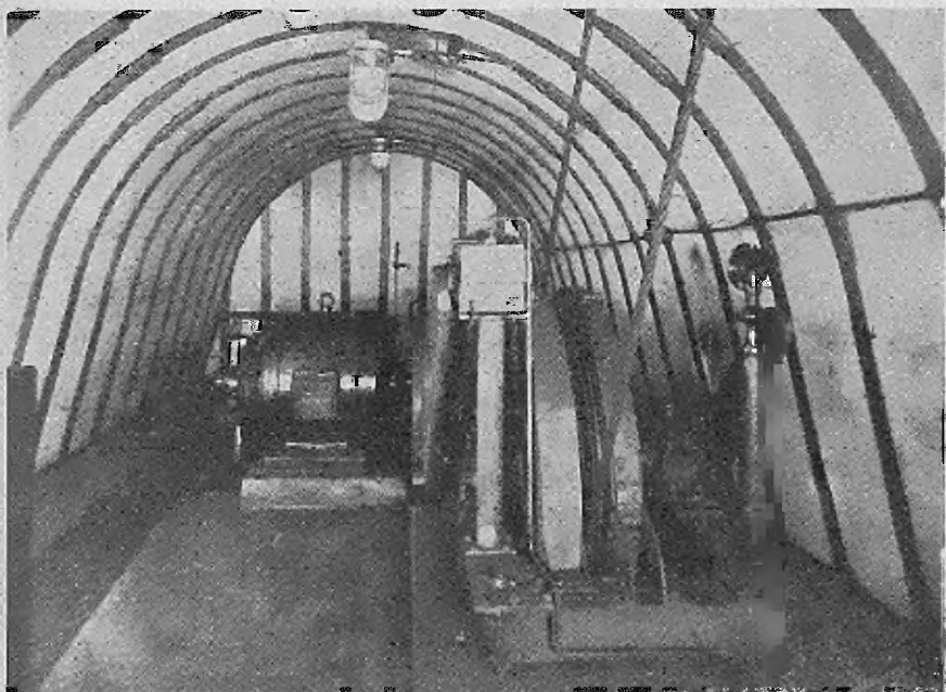
Abb. 13. Starrer dreiteiliger Gestellbogenausbau aus Potaleisen in einer Bremskammer zur Verstärkung des Betonformsteinausbaues.
