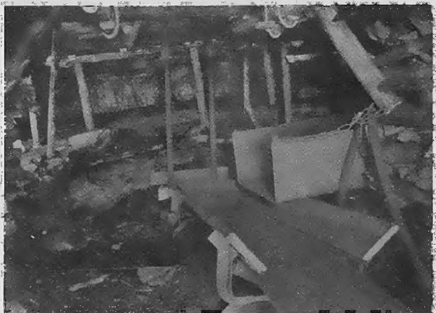
Abb. 71. Infolge Verwendung der Bandschleife schneidet die Umkehrrolle des Transportbandes mit der Abbaufont ab (Werfphoto: Demag).
