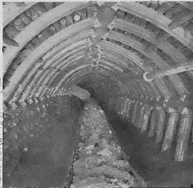
Abb. 53. Moll-Eisenpolygonausbau in einer Abbaustrecke bei halbfester Lagerung
