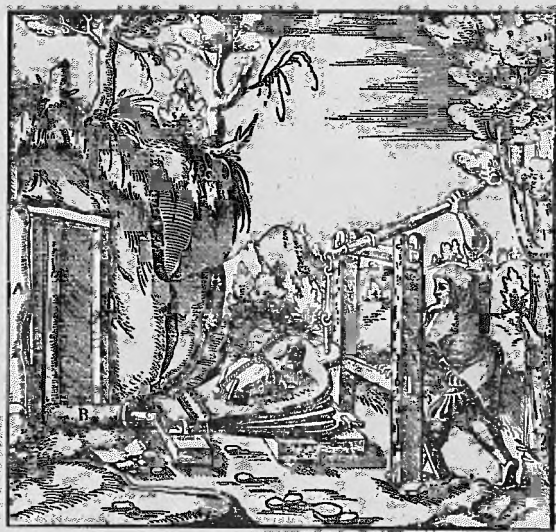
Abb. 12. Wetterführung mittels Blasebalg von Hand angetrieben
