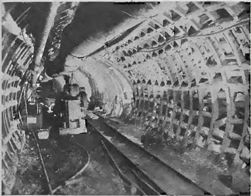
Abb. 7. Vierteiliger Ringausbau aus Potalbleisen in starrer Ausführung in einer im Auffahren begriffenen Richtstrecke
