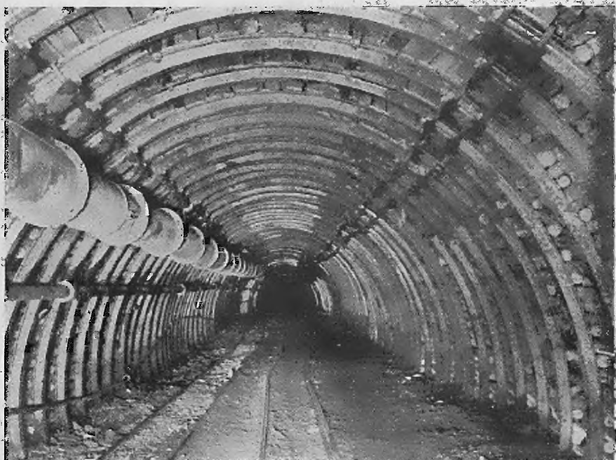
Abb. 36. Nachgiebiger dreiteiliger Gestellbogenausbau aus Toussaint-Heinemann-Profil,
