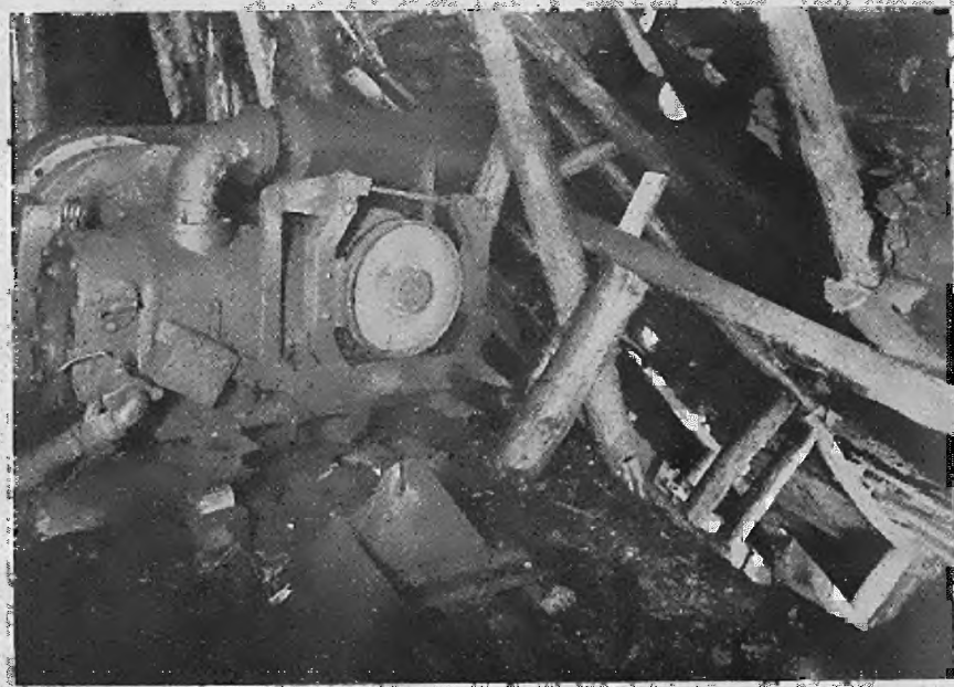
Abb. 84. Antriebsstation des Bremsförderers in der oberen Strecke eingebaut (Berlphoto; Demag).
