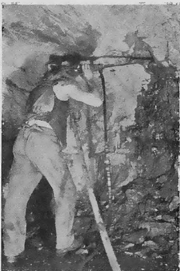
Abb. 97 Spülkopfböhrn mit Flottmann-Spülkopf. Praxis in einem Querschlag
