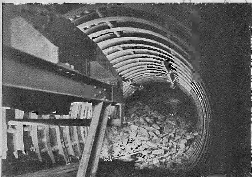
Abb. 15. Unbeschränkt viertelliger Ringausbau aus Pokaleisen in Verbindung mit protierten Spezial-Eisen in einem im Auffahren begriffenen Hauptquerschlag
