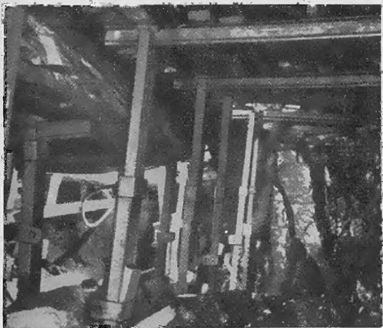
Abb. 54. Strebau mit nachgiebigen Schwarz-Stahlstempeln
