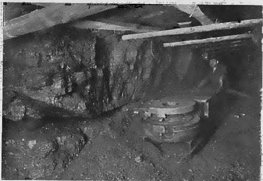
Abb. 26. Die Großschrammaschine Typ E 40 in Arbeitsstellung mit vorgepfändeten Kohlenstoß (Wertphoto Gebr. Eichhoff)
