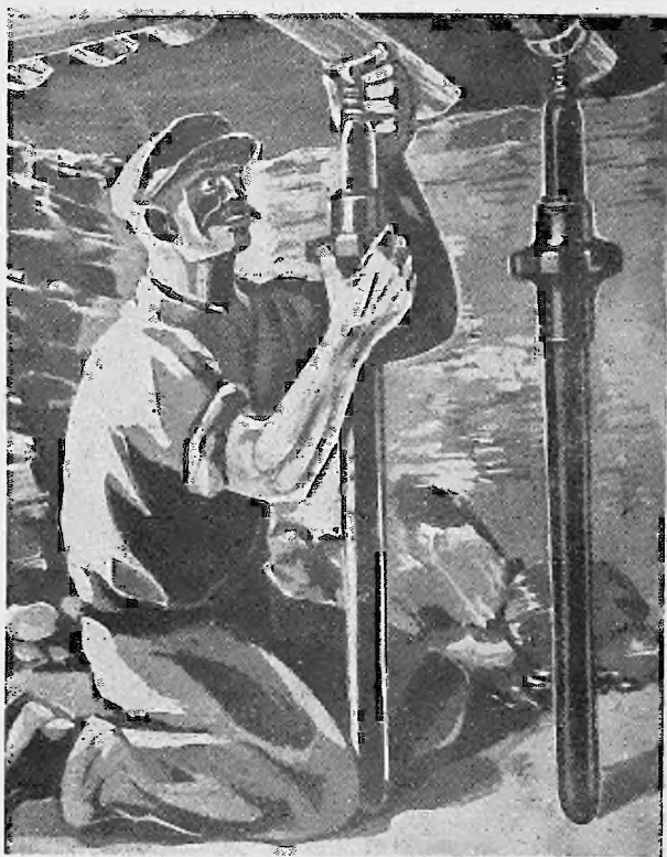
Abb. 60. Vorpfänden im Abbau mit eisernen Vorbaustempeln. fernung ohne Erschütterung des Hängenden. Eiserner Vorbaustempel und auch andere Stahltempel im Abbau der Flöze verringern demnach die Steinfallgefahr.
