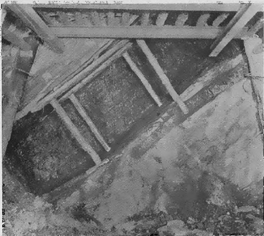
Abb. 41. Ausgefohltes Ort nach dem Schrämen mit der Säulenschräms- und Schlitzmaschine S/S/K (Wertphoto Heint. Korfmatt jr.).
