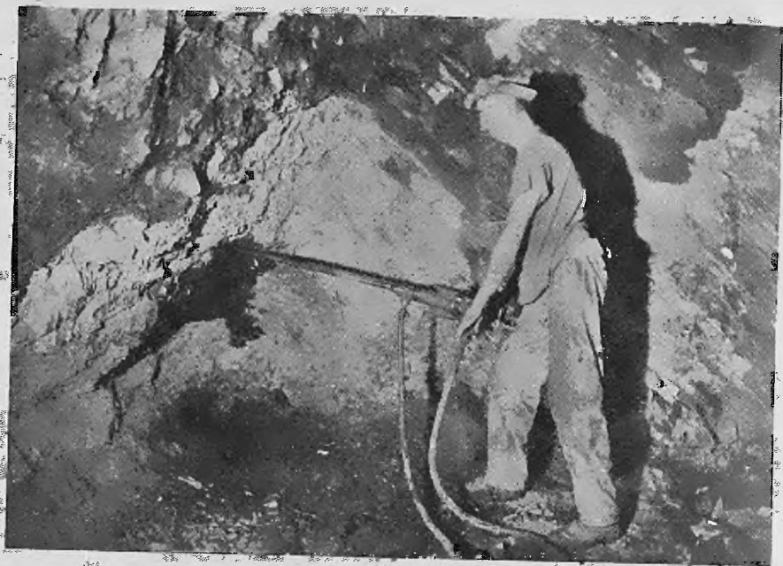
Abb. 99. Das Bohren mit Demag-Spülkopf im Querschlagvortrieb
