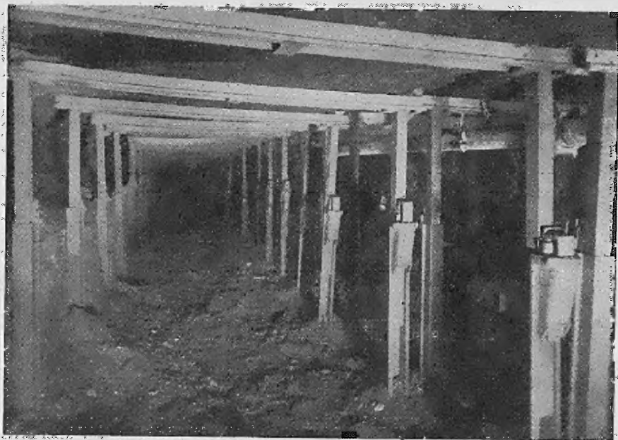
Abb. 37. Strebau aus mit Toussaint-Heinemann-Stahlstempel unter Verwendung von Schälwelleisen am Hangenden aus dem gleichnamigen Profil
