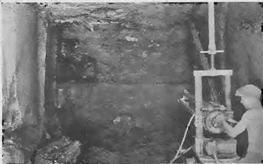
Abb. 41a. Die Säulenschräum- und Schlitzmaschine beim Schneiden des rechten Drüßstößes (Werktphoto Korfmann jr.).
