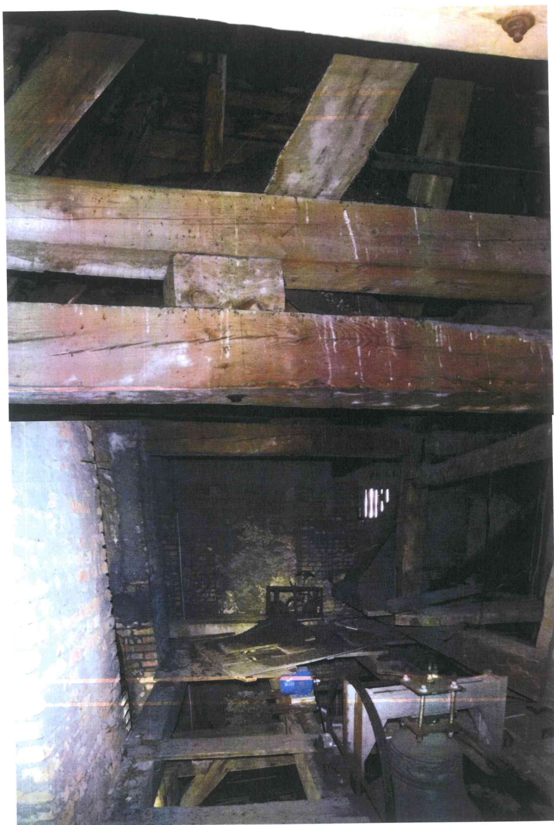
Ryc. 2. Wygląd strychu w miejscu lokalizacji nocka orzesionego Myotis emarginatus , na strychu wieży kościelnej w Sławkowie (5.09.2017).
