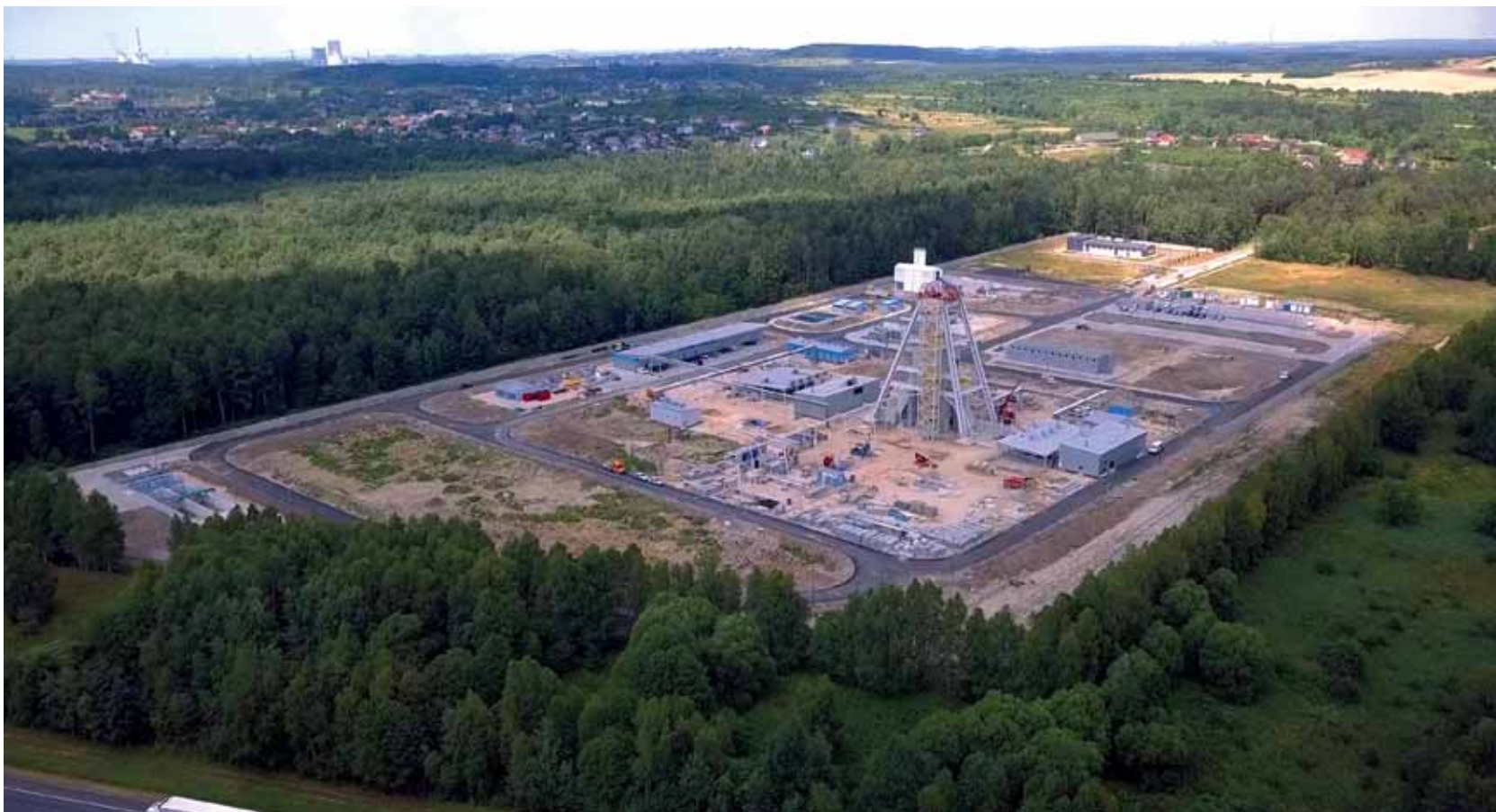
Na budowie naziemnej części szybu codziennie pracuje około 100 osób
