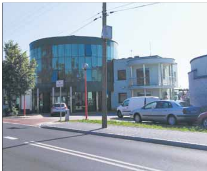
Wodociągi Jaworzno w 2019 r.
