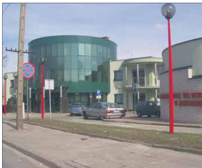
Wodociągi Jaworzno w 2009 r.
