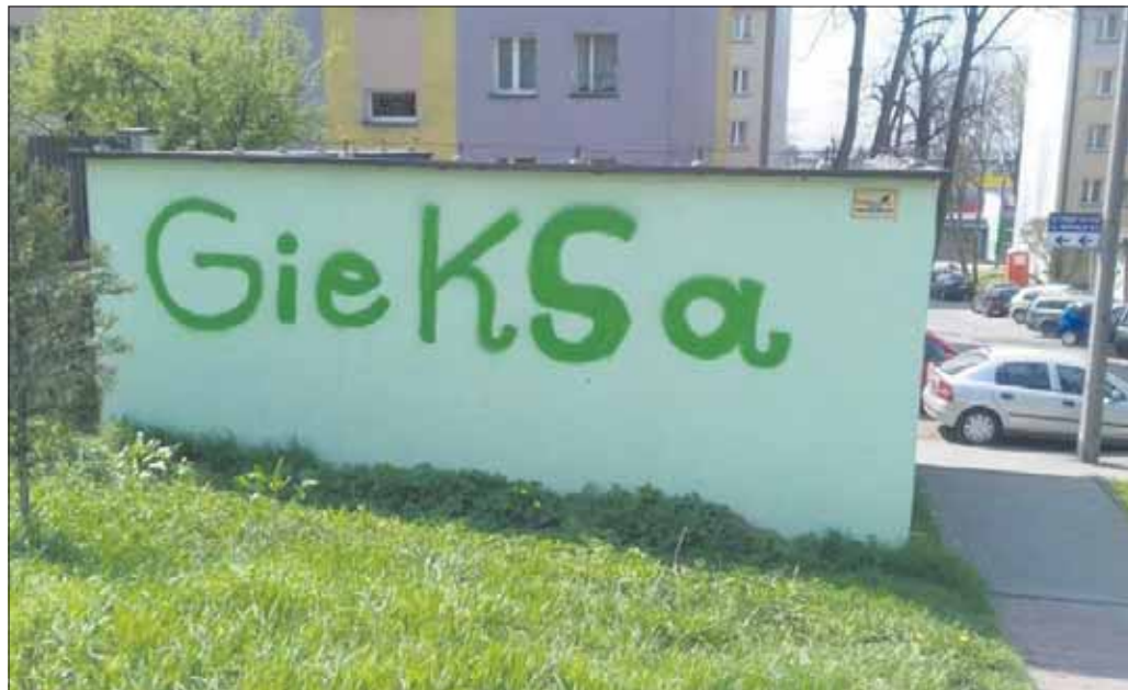
Świeżo pomalowany budynek został zdewastowany
