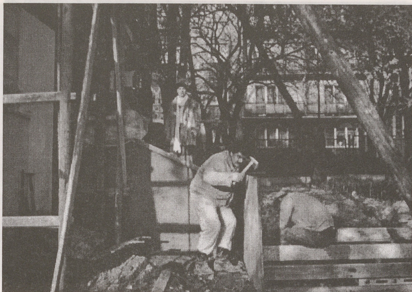
Mimo, że remont budynku Biblioteki Centralnej trwa, to wewnątrz dobiegają końca prace związane z ułożeniem zbiorów
