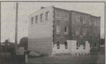
Trwają prace związane z ociepleniem siedziby Urzędu Gminy w Reńskiej Wsi
