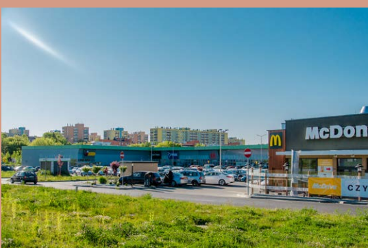
DNZ PW przed wyburzeniem, obecnie centrum handlowe.
