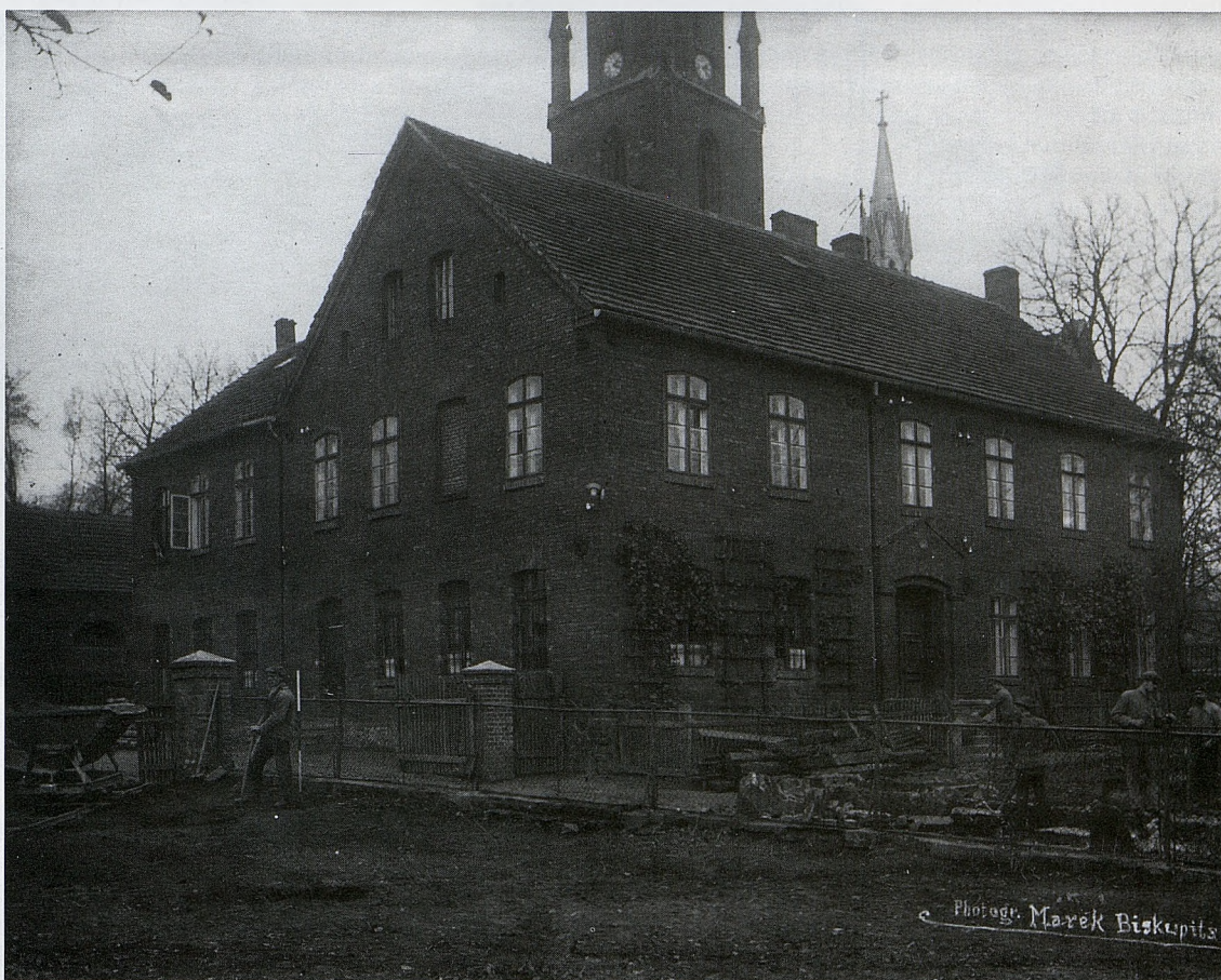
Budynek starej szkoły w trakcie prac rozbiórkowych w 1924 roku. W miejscu szkoły wzniesiono budynek biskupickiego ratusza.
