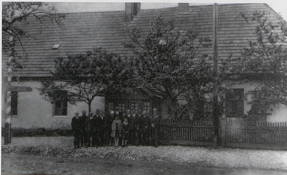
Budynek starej szkoły
