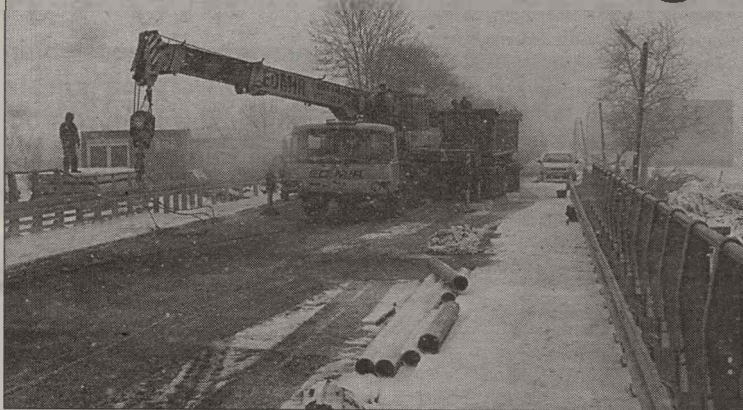
Nawet śnieżycy nie przeszkodziła w pracy przy remoncie mostu
