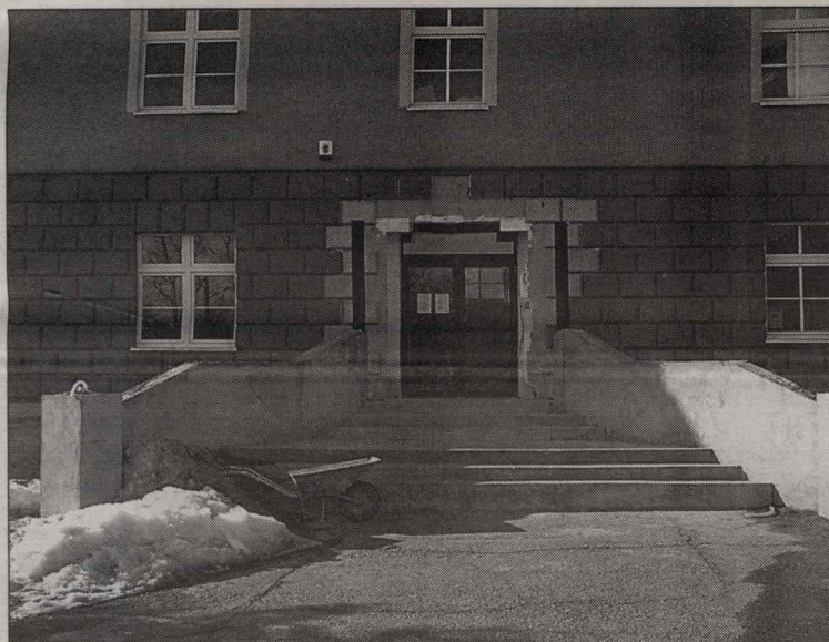
Budowlańcy czekają na lepszą pogodę, aby zrobić zadaszenie wejścia do urzędu gminy
