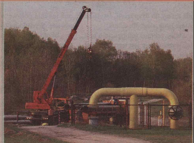
Aktualnie trwają prace przy odnodze Kanalu Gliwickiego
