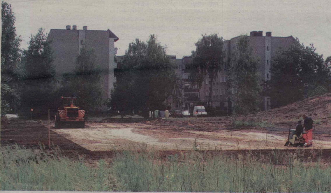
Na placu trwają prace przy budowie boiska
