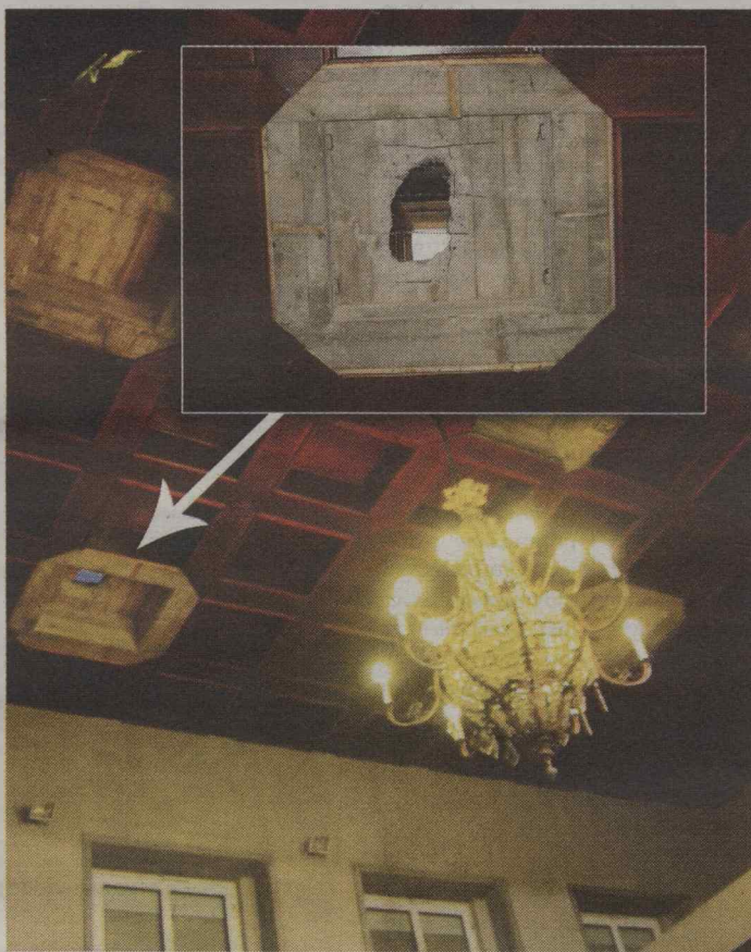
Aby pobrać próbki ze stropu, trzeba było rozebrać kasetony.
