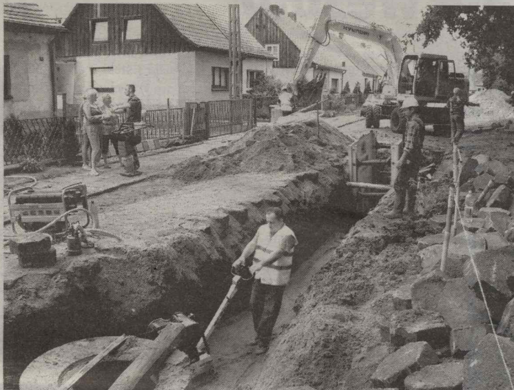
Roboty przy ul. Emilii Plater przebiegają dosyć sprawnie. Mieszkańcy mają jednak wiele pytań i wątpliwości.
