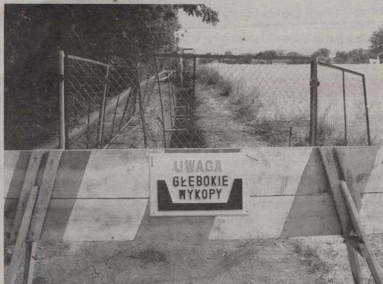
Na razie od pompowni przy ul. Piastowskiej w stronę oczyszczalni ścieków wykonano ok. 150 m kanału tłoczego
