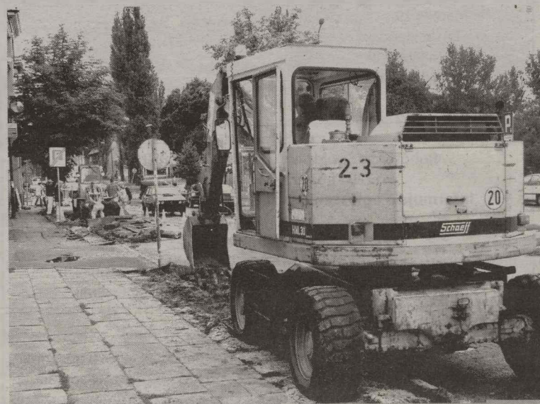
Na Grunwaldzką wjechał ciężki sprzęt i prace rozpoczęto.
