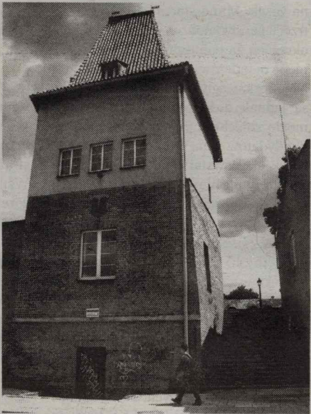
Na razie powstanie muzeum samorządowego w Kędzierzynie-Koźlu blokuje Warszawa
