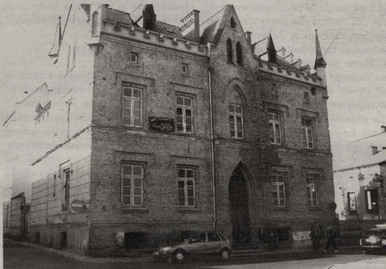
Na remont dawnego szpitala, w którym powstanie „Centrum Charytatywno-Kulturowe” potrzeba jeszcze ok. 2 mln zł.
