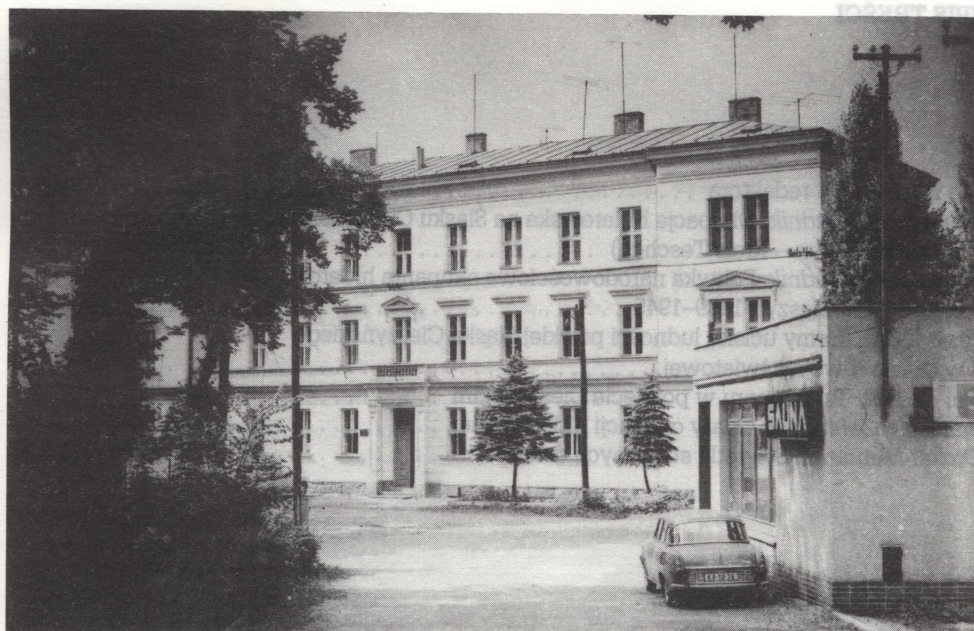
Budynek byłej siedziby „Gestapo” w Czeskim Cieszynie
