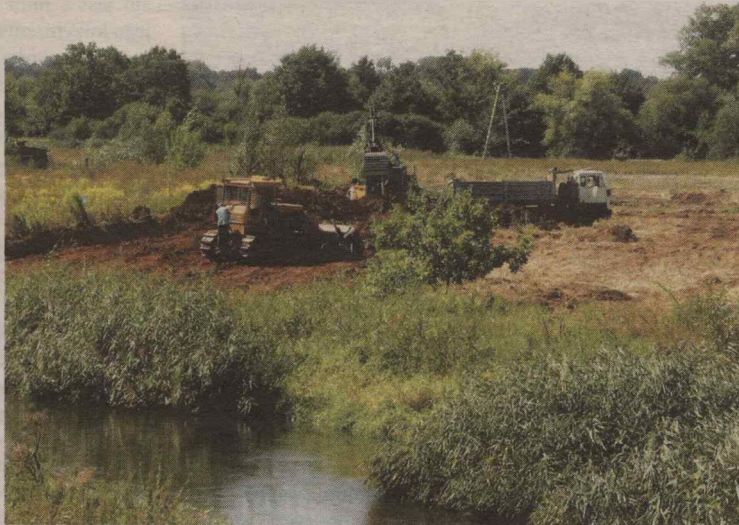
W pobliżu ronda Milenijnego i rzeki Kłodnicy ruszyły pierwsze prace przy budowie kolejnej części obwodnicy.
