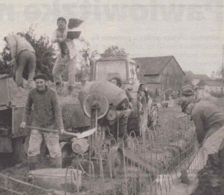
Praca wre - trwa zalewanie potężnych ław fundamentowych.
