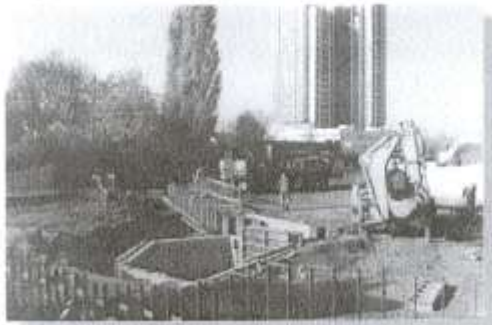
Przebudowa kanalizacji w centrum Miasta
