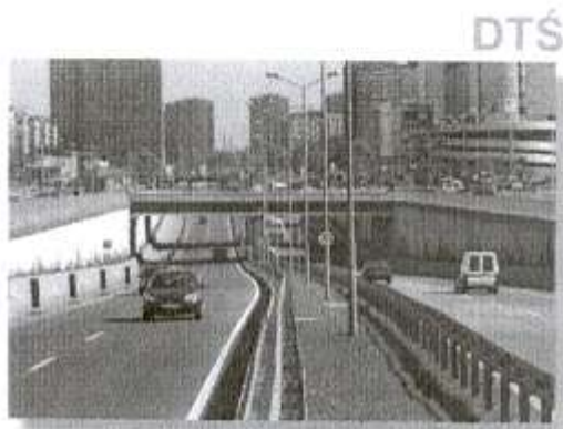
Zrealizowany odcinek DTŚ
