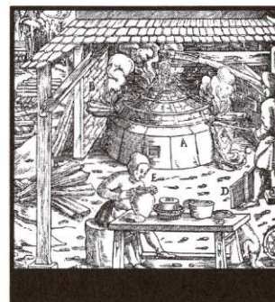
Sklepienie pieca A. Jego podstawą B. Odpowietrznik C. Złota D. Polny E. Rostek podlegający według czeskiego sposobu rudy głęjt F. Kanał G. Głęjt H. Dolny odstęp I. Pręt K. Rurki L.
