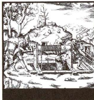
Szyby pionowe. Szyb nie dotarł do wyrobiska A. Szyb połączony z wyrobiskiem B. Szyb przed rozpoczęciem drażnienia wyrobiska C. Wyrobisko D.
