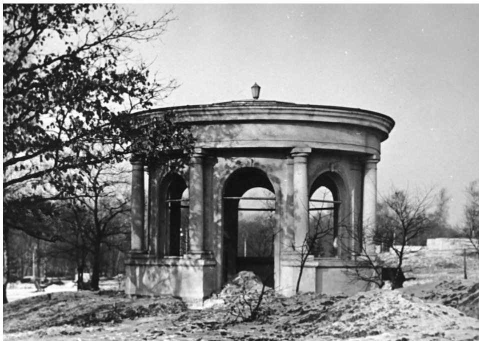
Il. 42. Kiosk spożywczy w budowie. APK, zesp. 480, sygn. 2/17.
