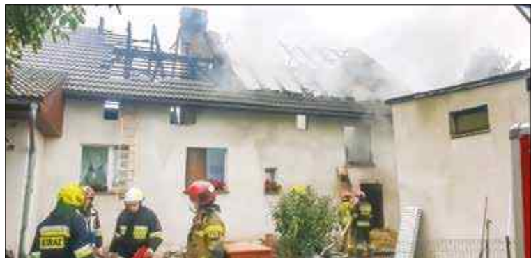
Spłonął dach i poddasze
